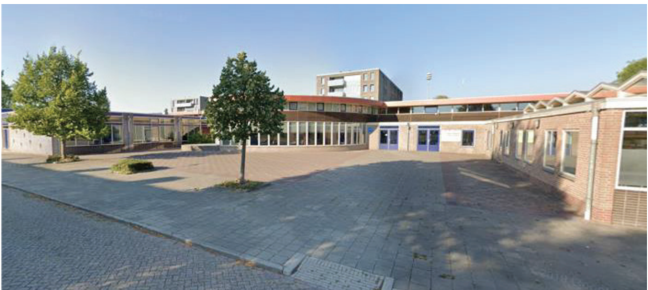
Het voormalige Ashram College
