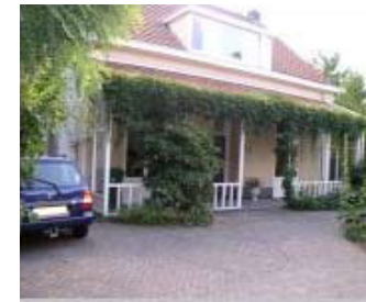
veranda bij patio-woningen en woningen aan het hof
