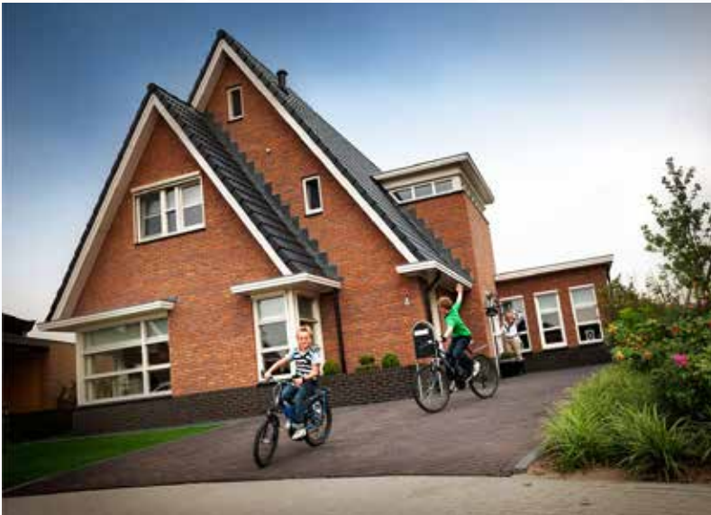
Gevels van metselwerk
