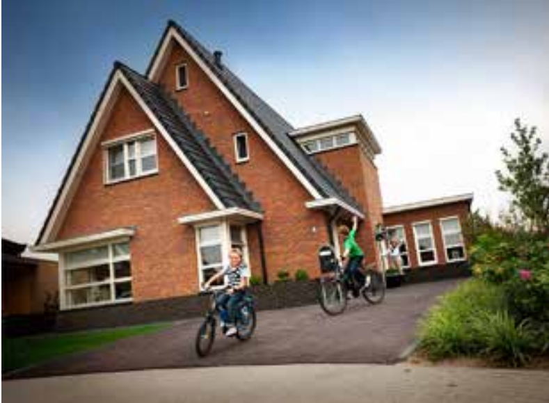
Gevels van metselwerk
