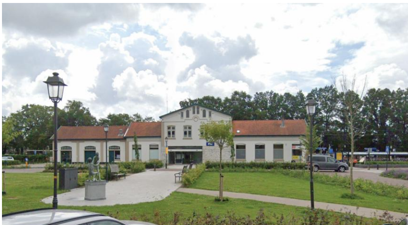
Station Nijkerk in 2025. Bron: Fier Architecten.
