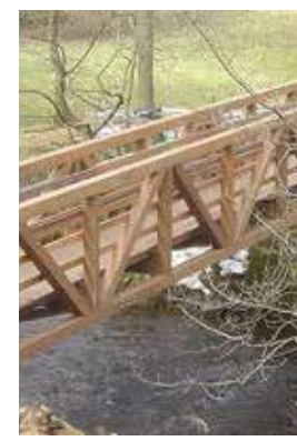
Eigentijdse vakwerkbrug hout
