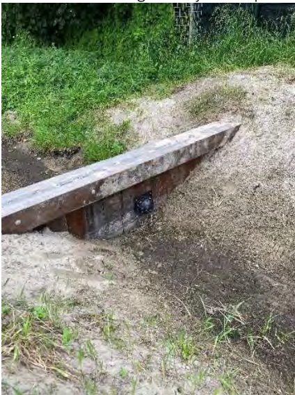
Figuur 4 Type knijpconstructies in stuwen
