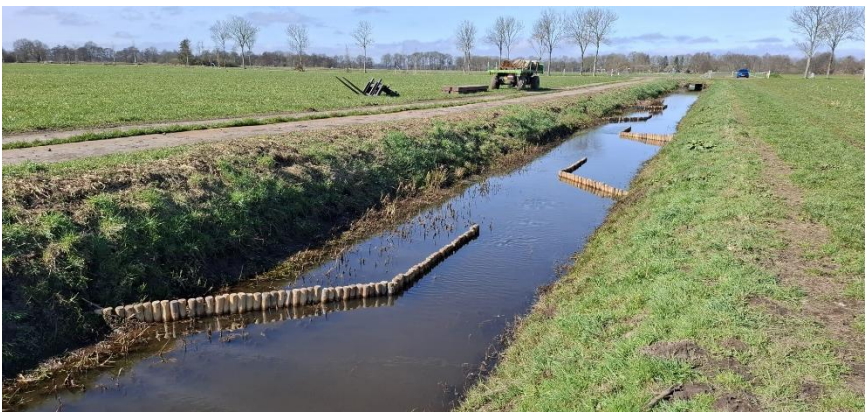
Figuur 4-2 Voorbeeld van recent aangebrachte Bach im Fluss maatregel in de benedenloop van de Runslot
