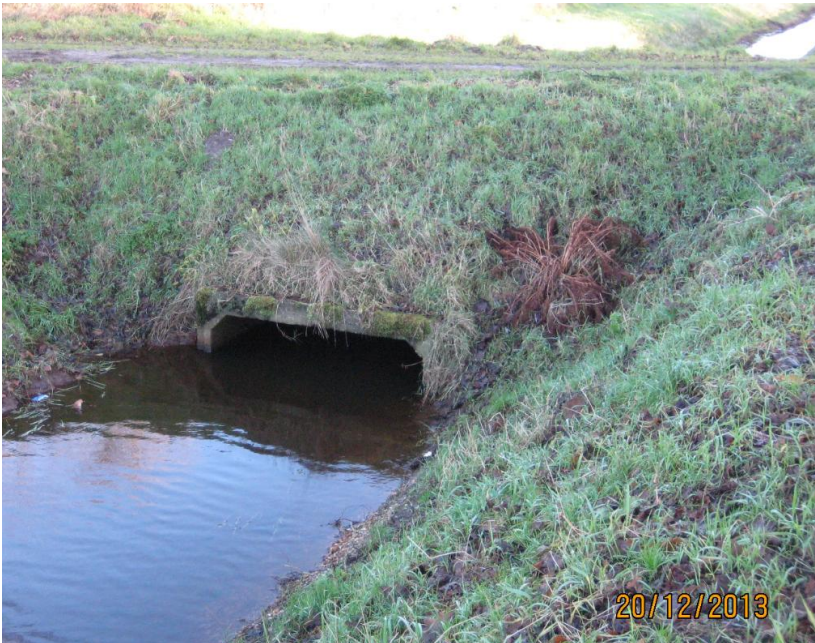
Figuur 4-10 Te herleggen duiker Kerkpad
