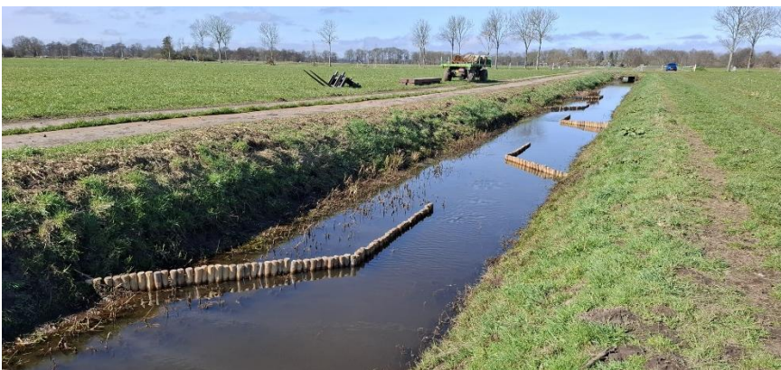
Figuur 4-5 Voorbeeld van recent aangebrachte Bach im Fluss maatregel in de benedenloop van de Runsloot
