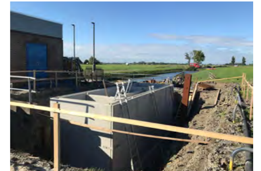
Aanleg vispassage Sichterman
