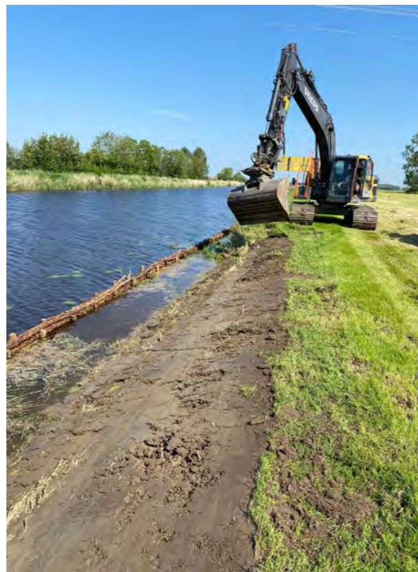
Aanleg natuurvriendelijke oevers Aduarderdiep
