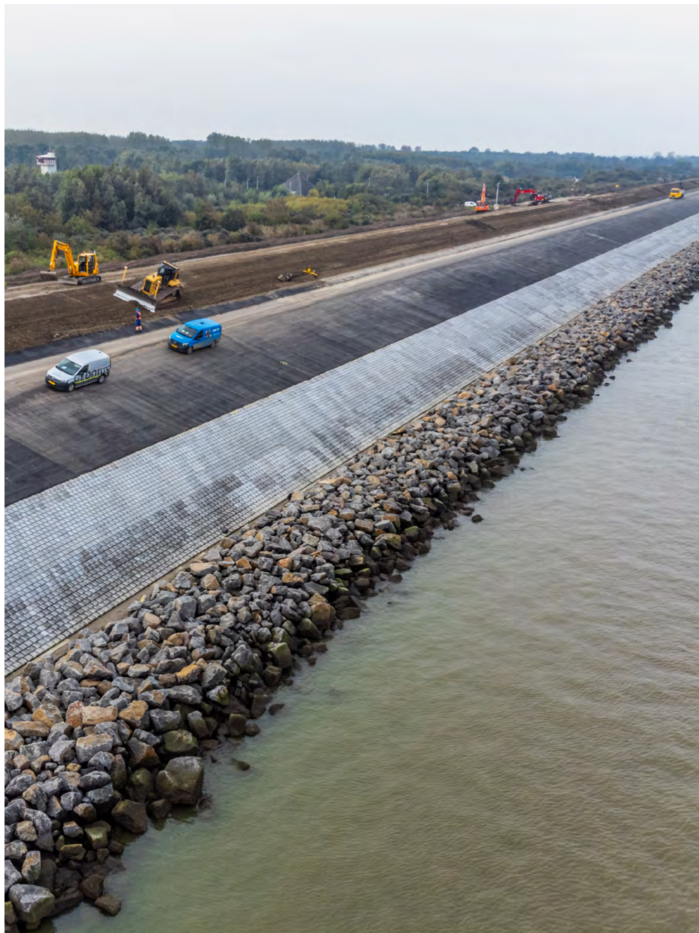
Werk aan Lauwersmeerdijk
