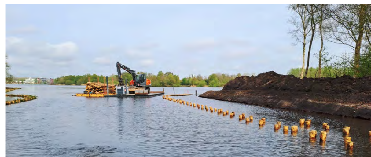
Plaatsen wiepenbeschoeiing Paterswoldsemeer
