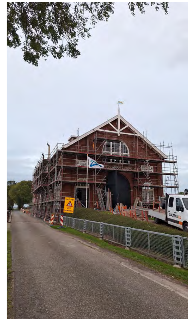
Dakrenovatie gemaal De Waterwolf
