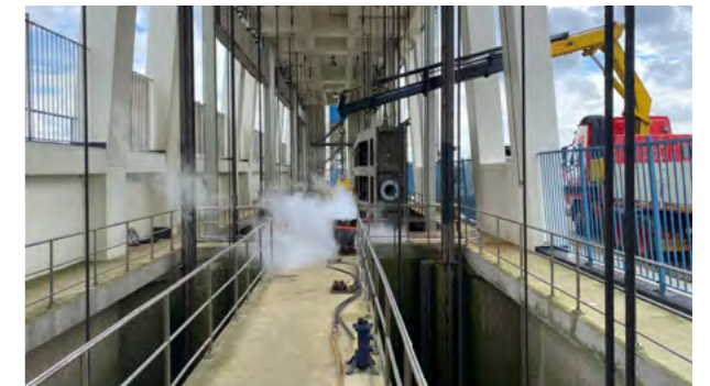
Onderhoud R.J. Cleveringsluizen
