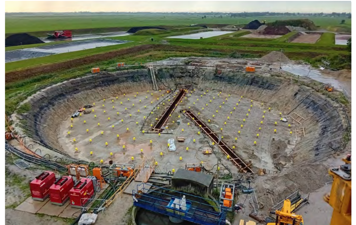
Ontgraven rotowall nieuwe zuivering Gaarkeuken
