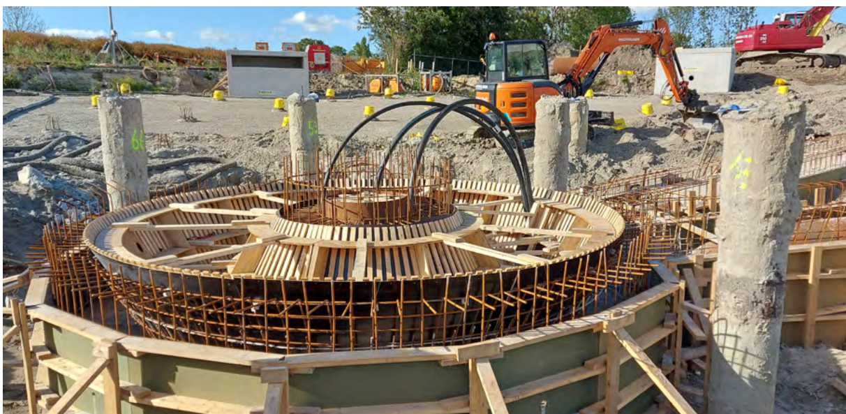
Hart van de nabezinktank bij RWZI Gaarkeuken
