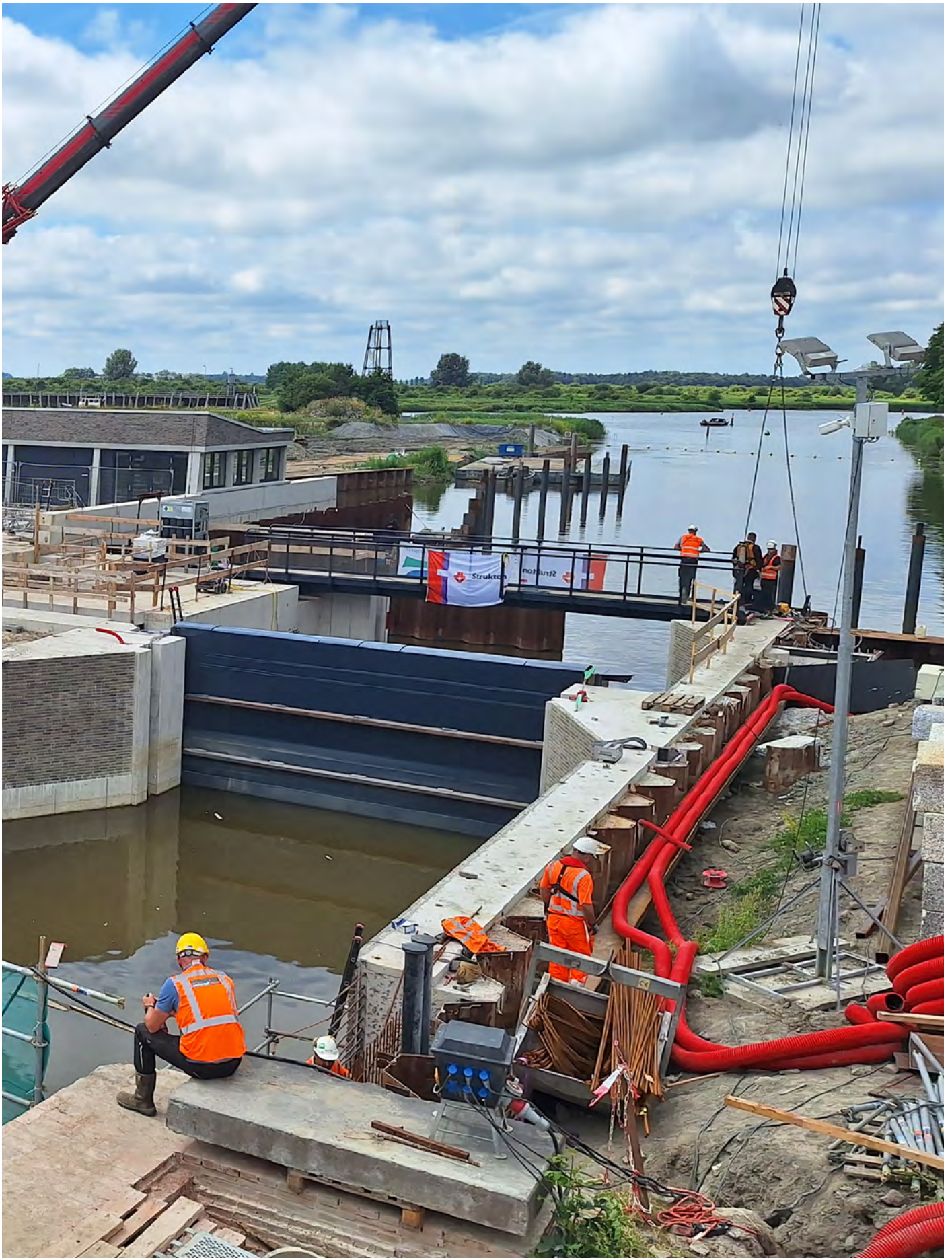
Plaatsing van de nieuwe stalen sluisdeur in Zoutkamp
