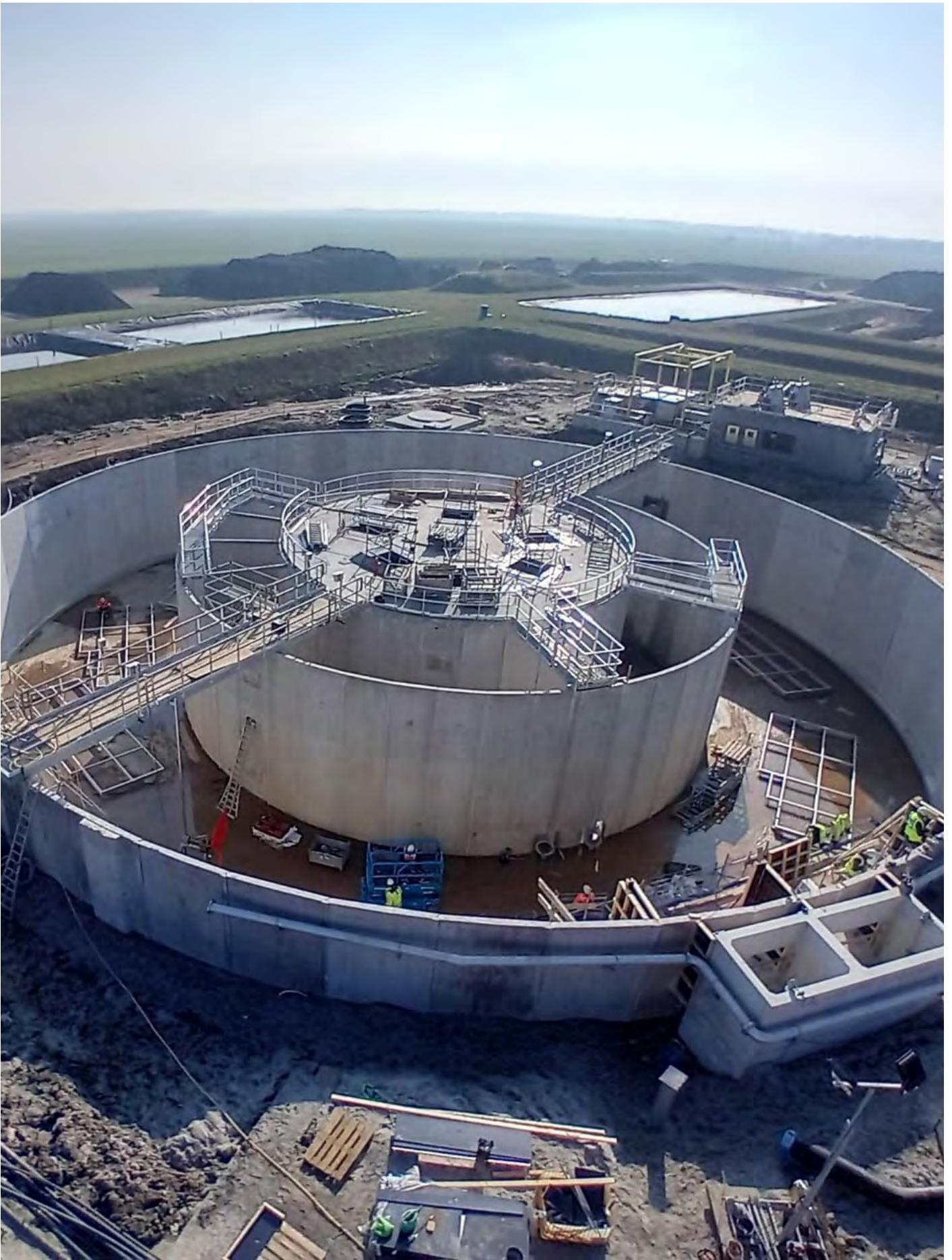
Bouw van de nabezinktank bij RWZI Gaarkeuken
