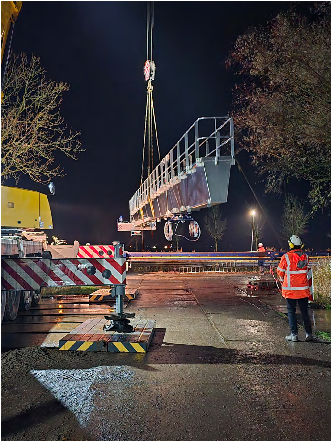
Plaatsing van de nieuwe ruimerbrug voor de rioolwaterzuivering (RWZI) in Gaarkeuken
