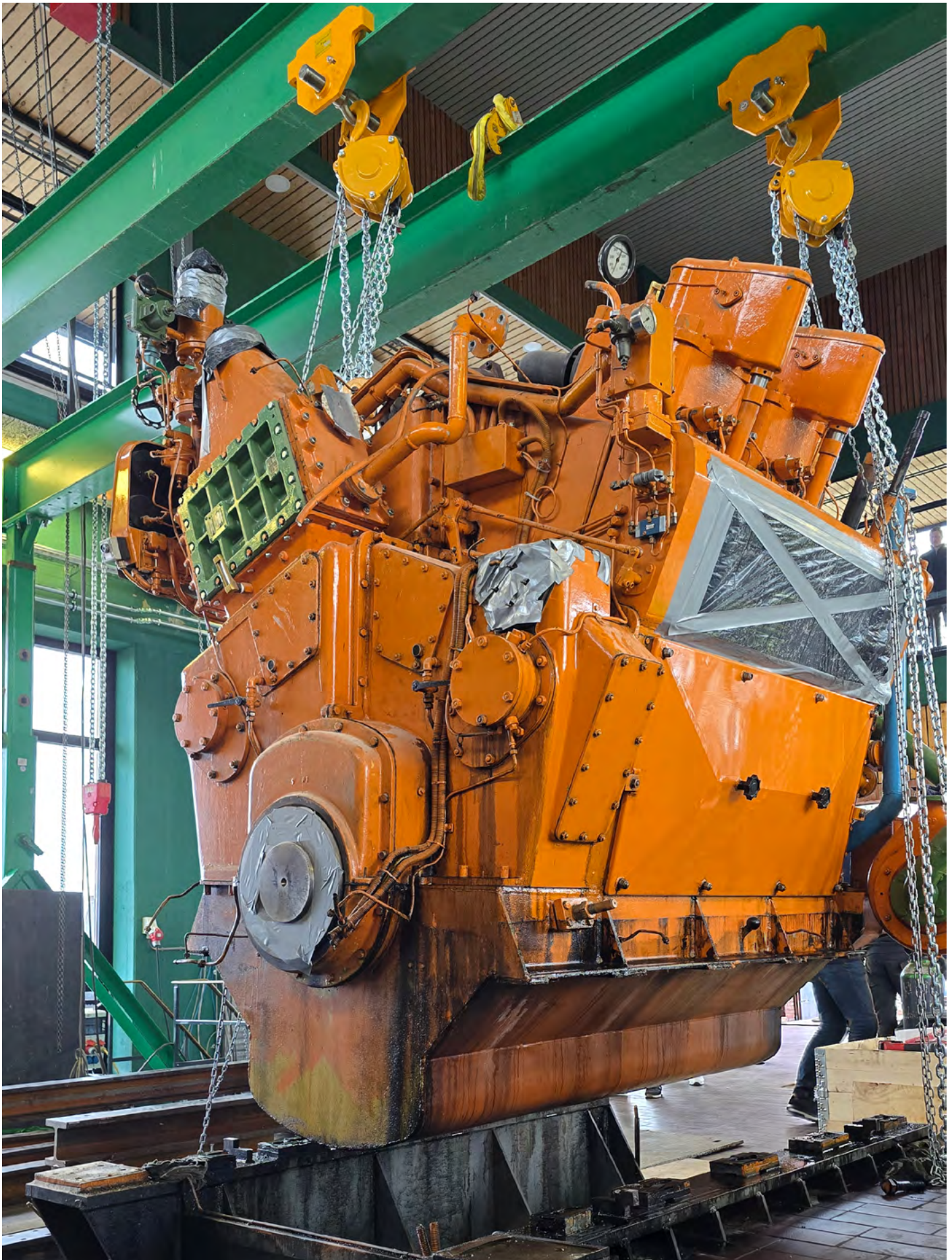
Het ophijzen en vervangen van de motoren in het boezemgemaal De Drie Delfzijen te Delfzijl
