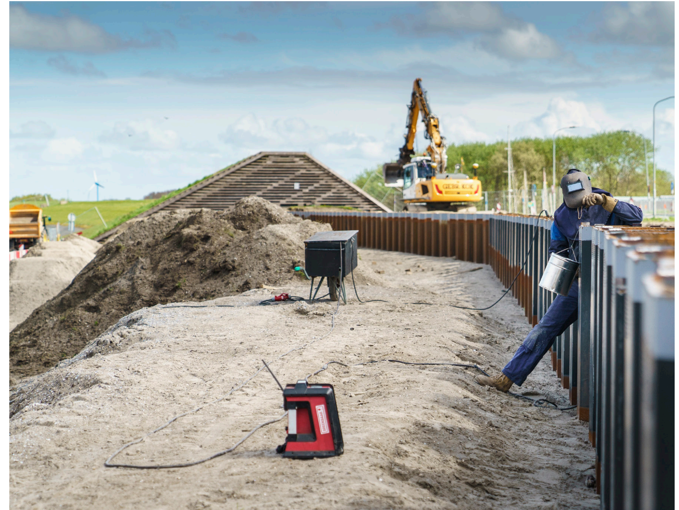
Werkzaamheden dijkversterking Lauwersmeerdijk-Vierhuizengat.
