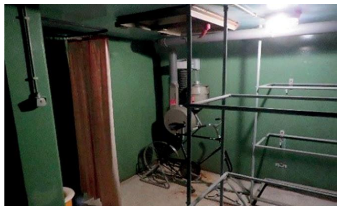
Figuur 7 - Atoomschuikelder onder de Drie Delfzijen.
