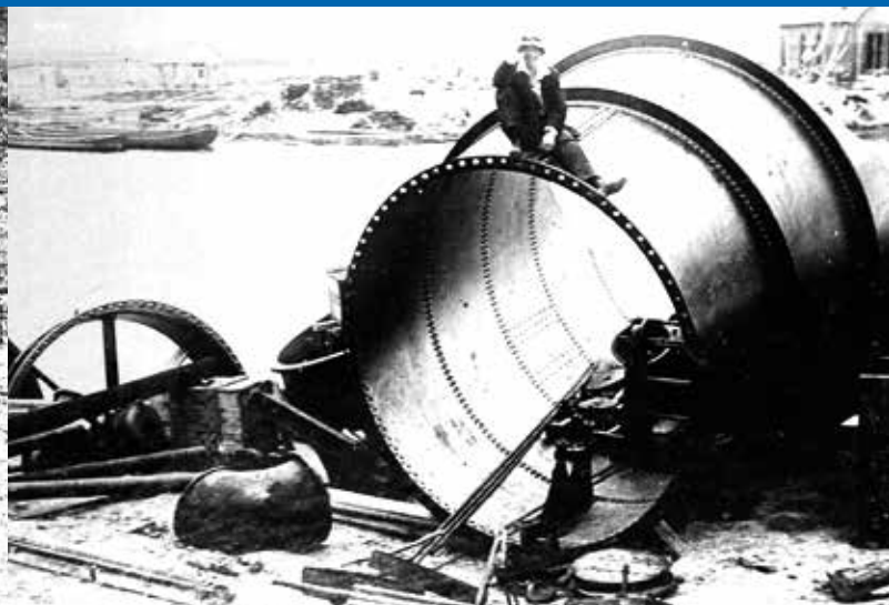
Een deel van een wateruitlaat van het gemaal De Waterwolf.
