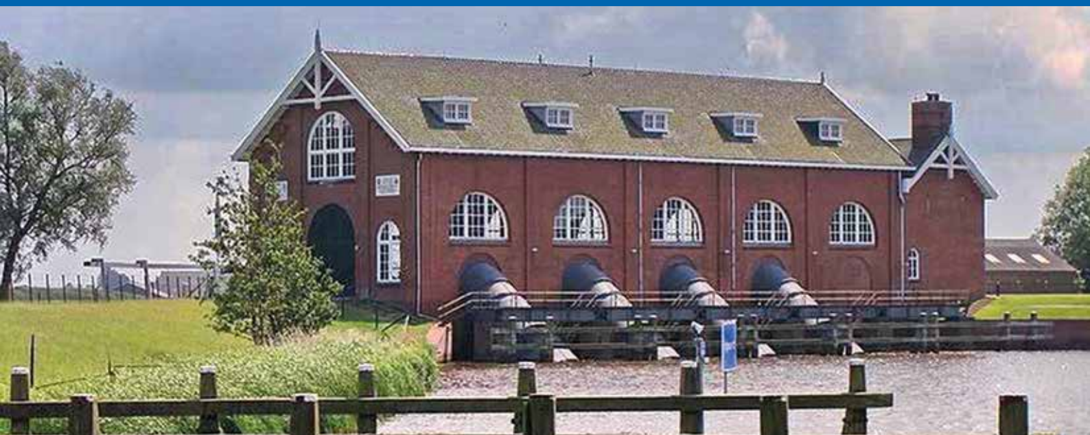
Het gemaal De Waterwolf nu. Via de vier grote sluiskokers aan de achterzijde van het gemaal wordt het water vanuit de Kommerzijlsterriet in het Reitdiep gepompt.
