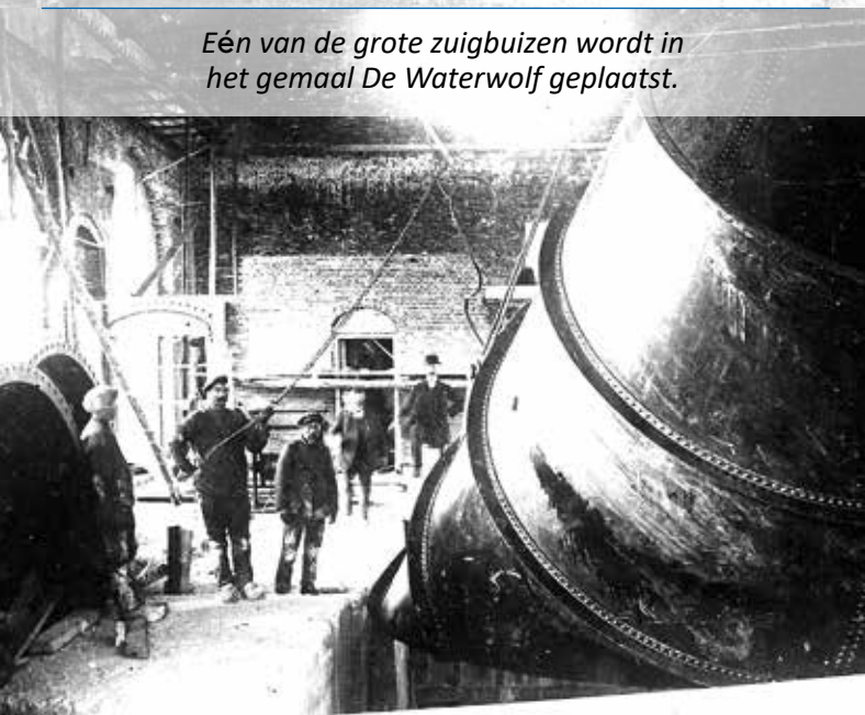
De aanleg van de inlaatzijde van het gemaal De Waterwolf aan de kant van de Kommerzijlsterrijt.
