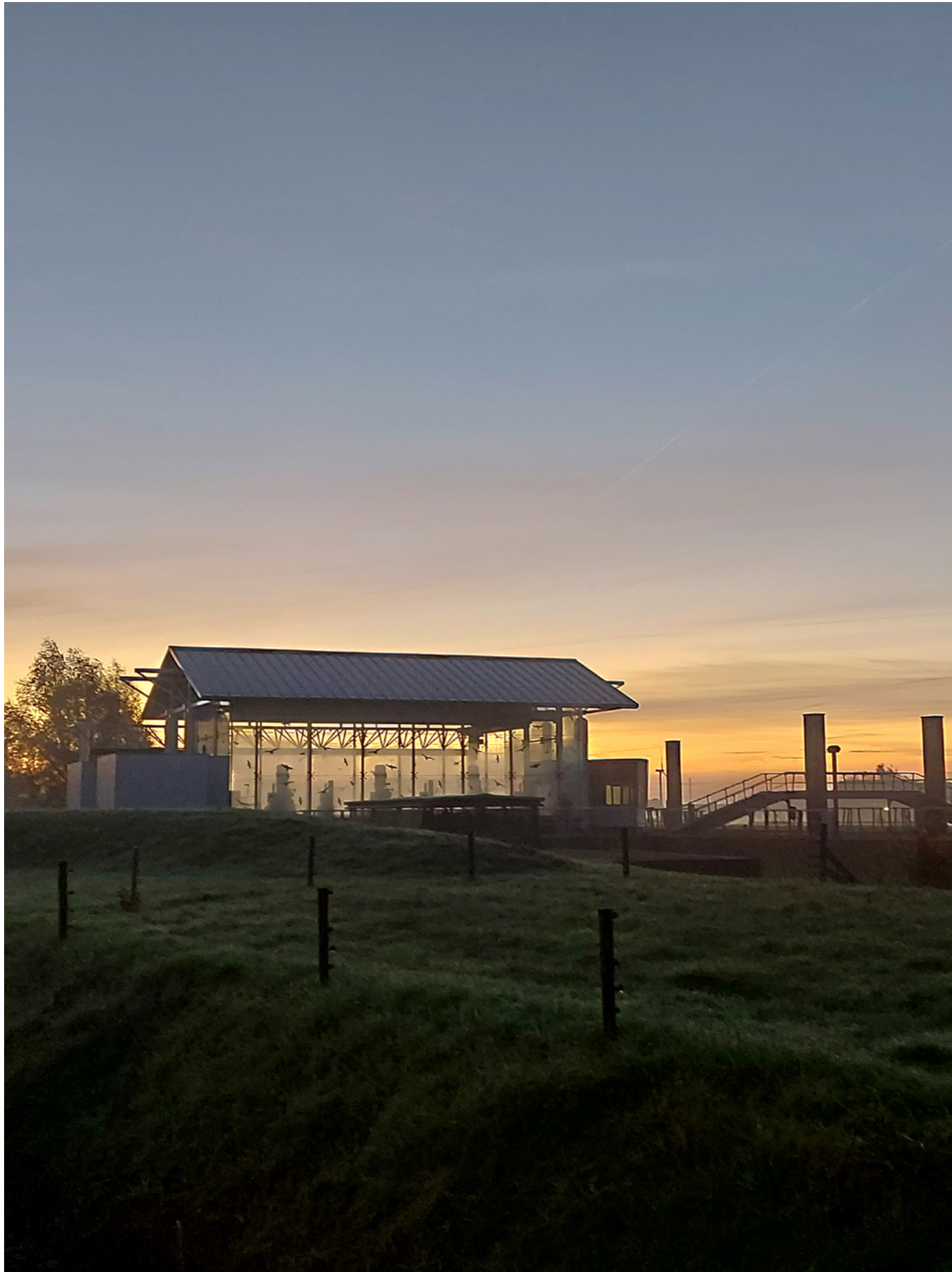
Gemaal Den Deel aan het Boterdiep
