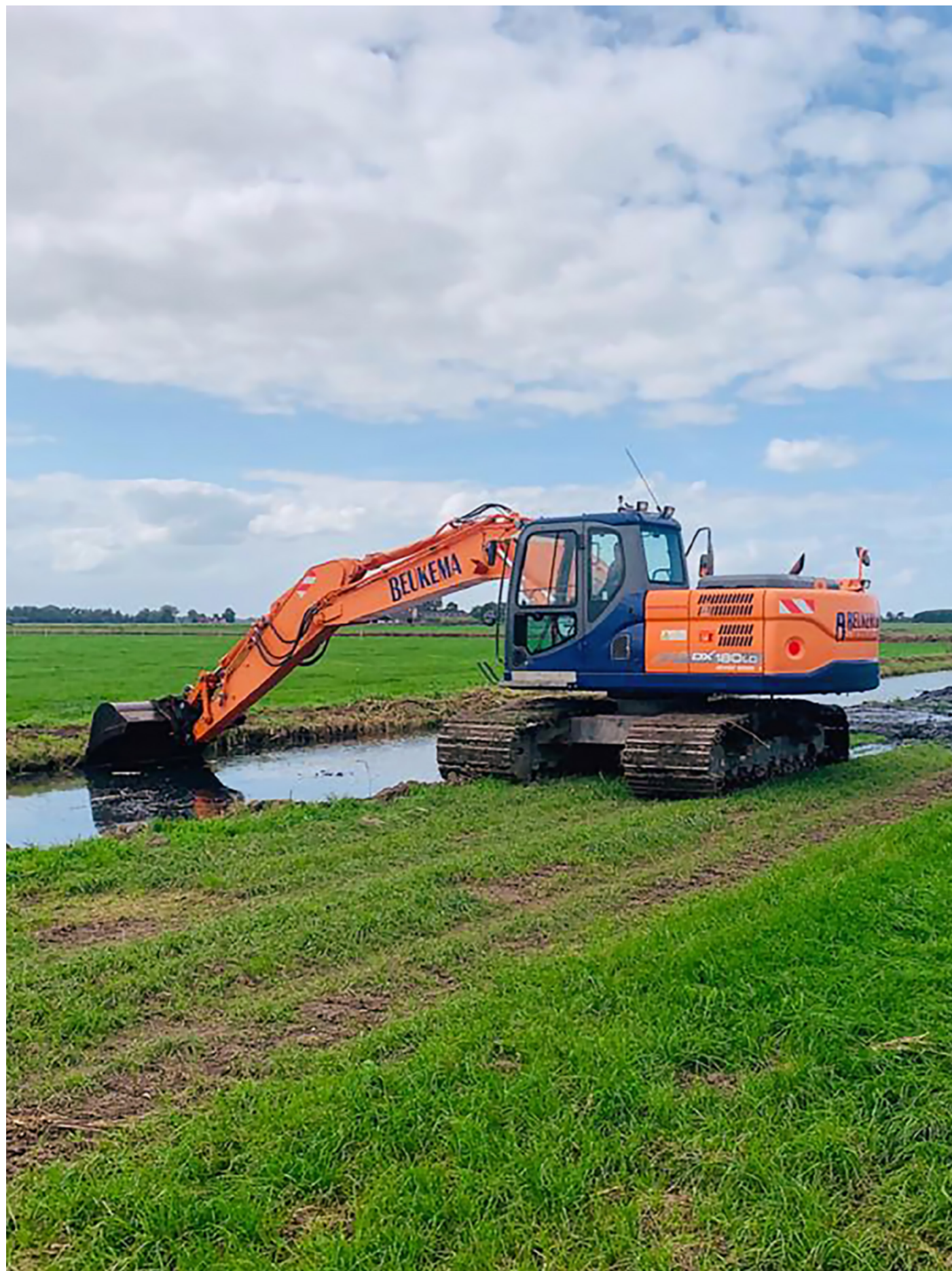
Baggeren van watergangen
