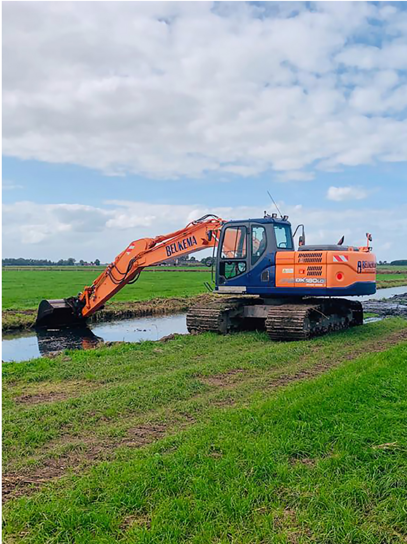
Baggeren van watergangen
