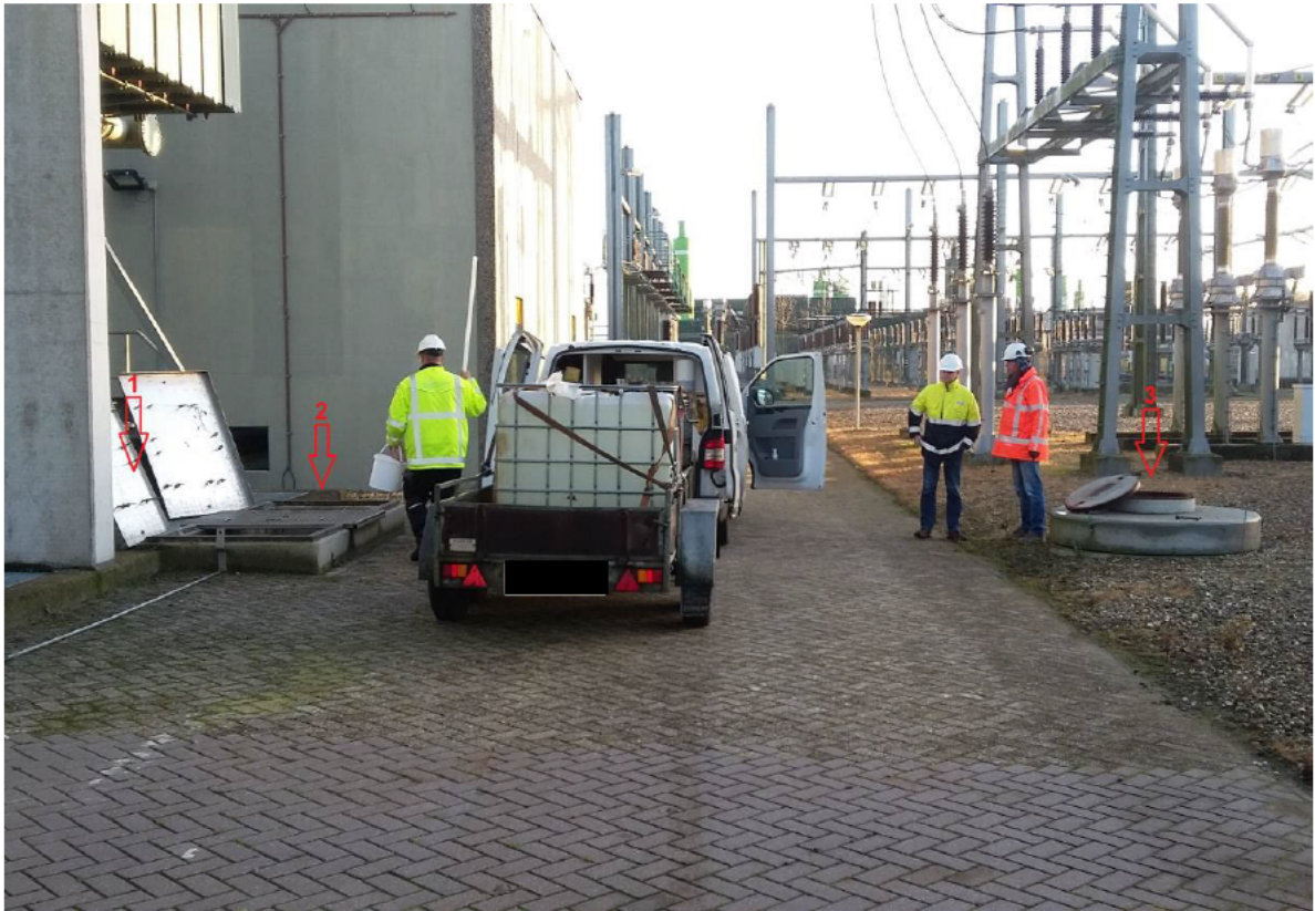
1 = putkelder onder trafo's. 2 = controleput en 3 = olie-waterafscheider
