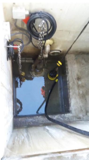
1 = putkelder onder trafo's. 2 = controleput en 3 = olie-waterafscheider
