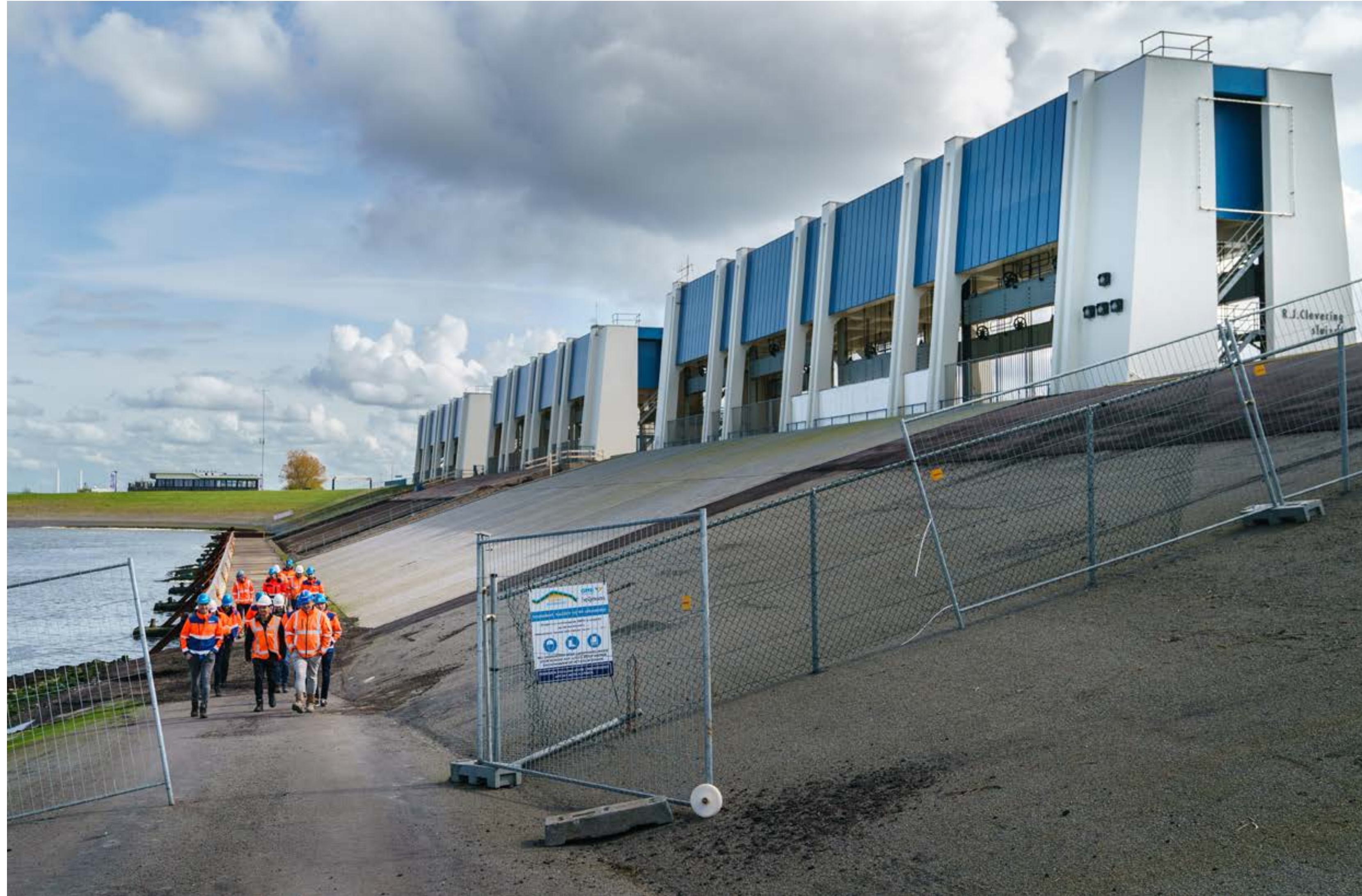
Bij de Cleveringsluizen wordt water uit het Lauwersmeer bij een lage waterstand op zee 'onder vrij verval' gespuid. In een toekomst met een hogere zeespiegel is dat niet meer vanzelfsprekend.
