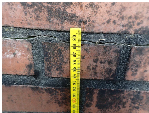
Foto 3.2: Scheur in voegwerk
