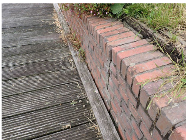
Foto 6.5: Scheur, constructief
