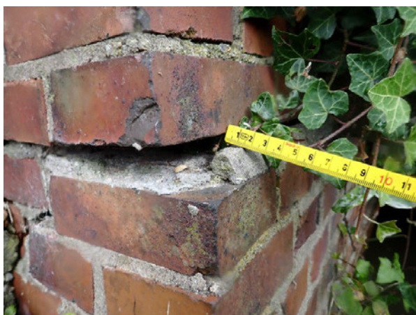
Foto 4.1: Scheur, constructief
