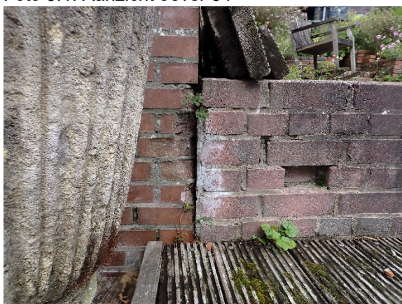
Foto 3.3: Uitgebroken metselwerk
