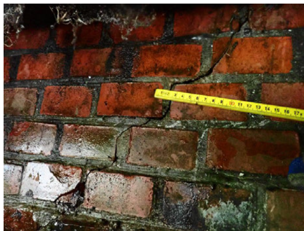
Foto 6.2: Scheur, constructief
