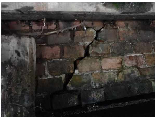
Foto 5.1: Scheur, constructief
