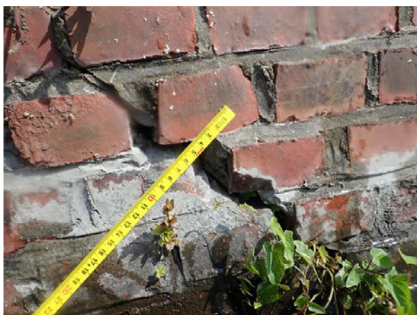
Foto 5.1: Scheur, constructief
