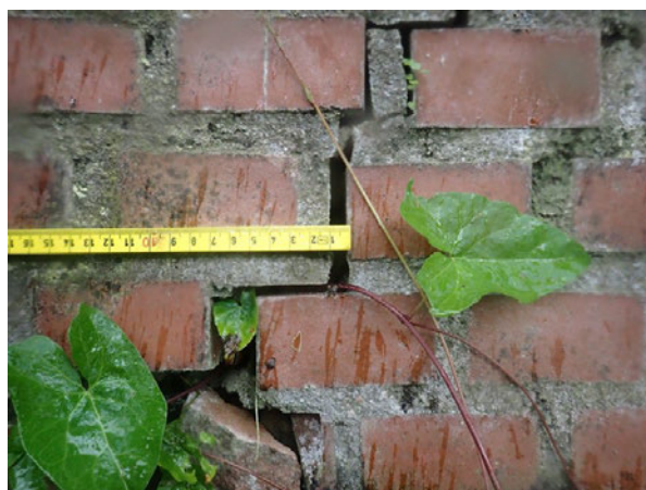
Foto 6.2: Scheur, constructief
