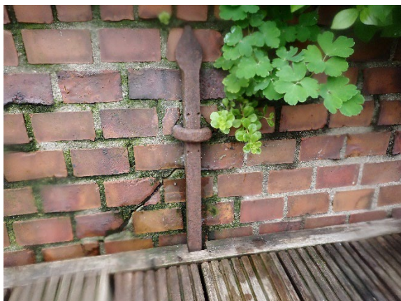
Foto 12.1: Scheur, constructief
