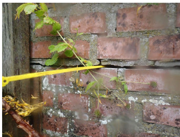
Foto 7.2: Scheur, constructief
