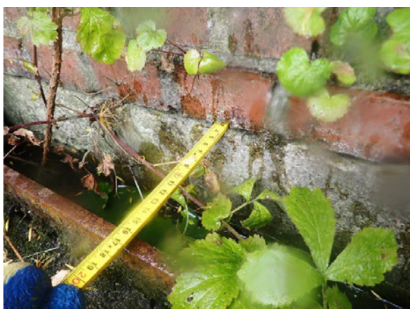
Foto 7.3: Fundering, verzakking
