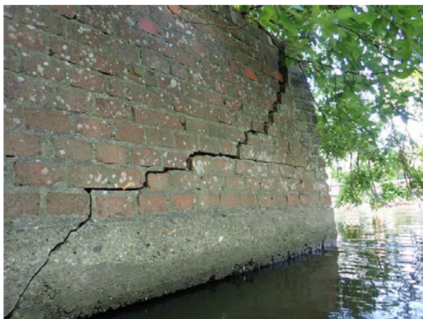
Foto 8.1: Scheur, constructief
