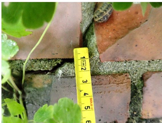
Foto 12.2: Scheur, constructief
