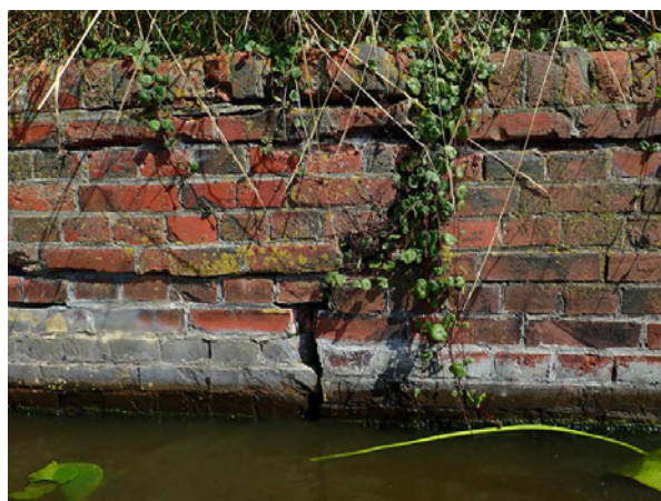
Foto 5.2: Scheur, constructief
