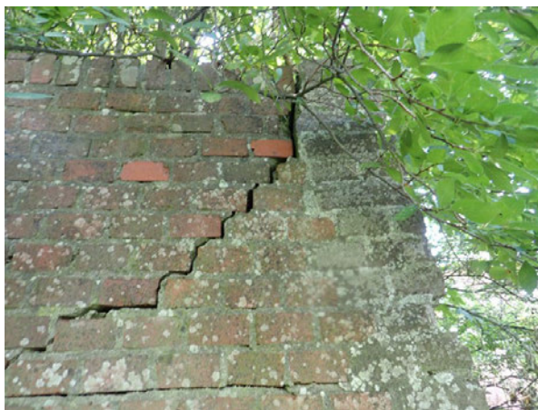
Foto 8.2: Scheur, constructief
