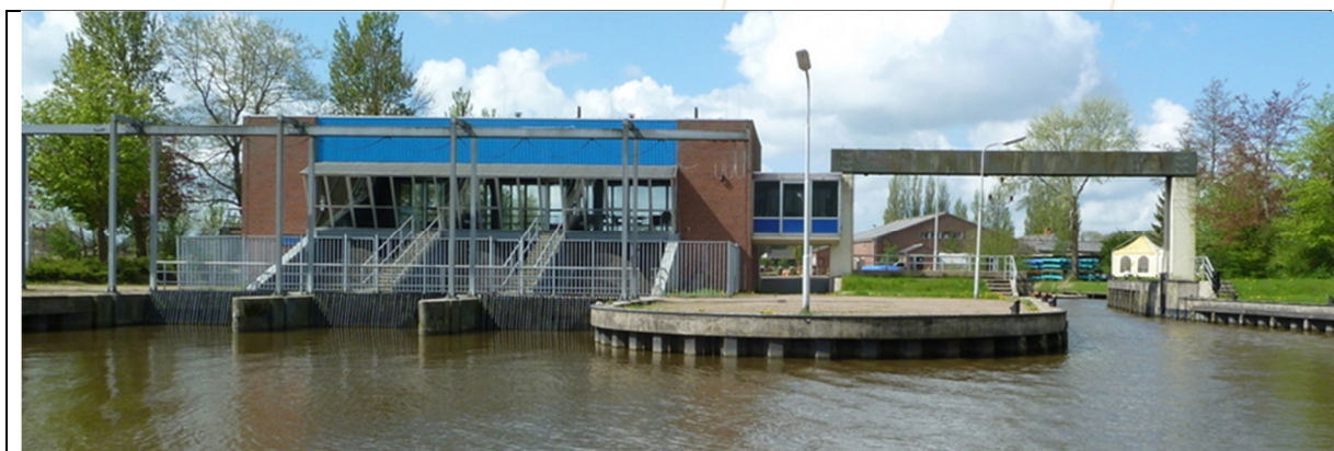
Figuur 3.3 HD Louwes gemaal en (geopende) keersluis
