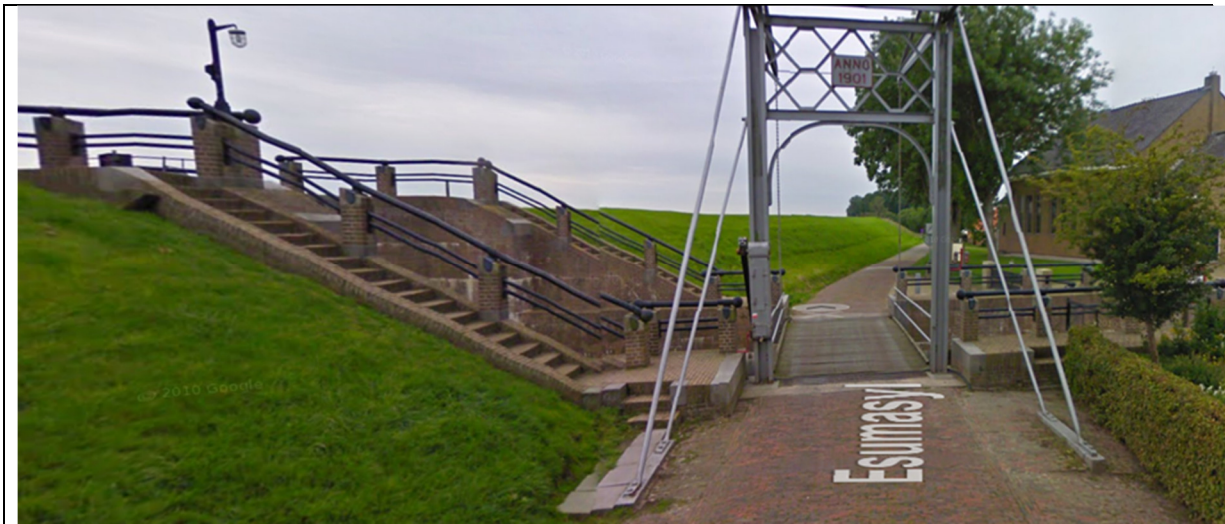
Figuur 3.4 Sluis Ezumazijl met gemaal op de achtergrond
