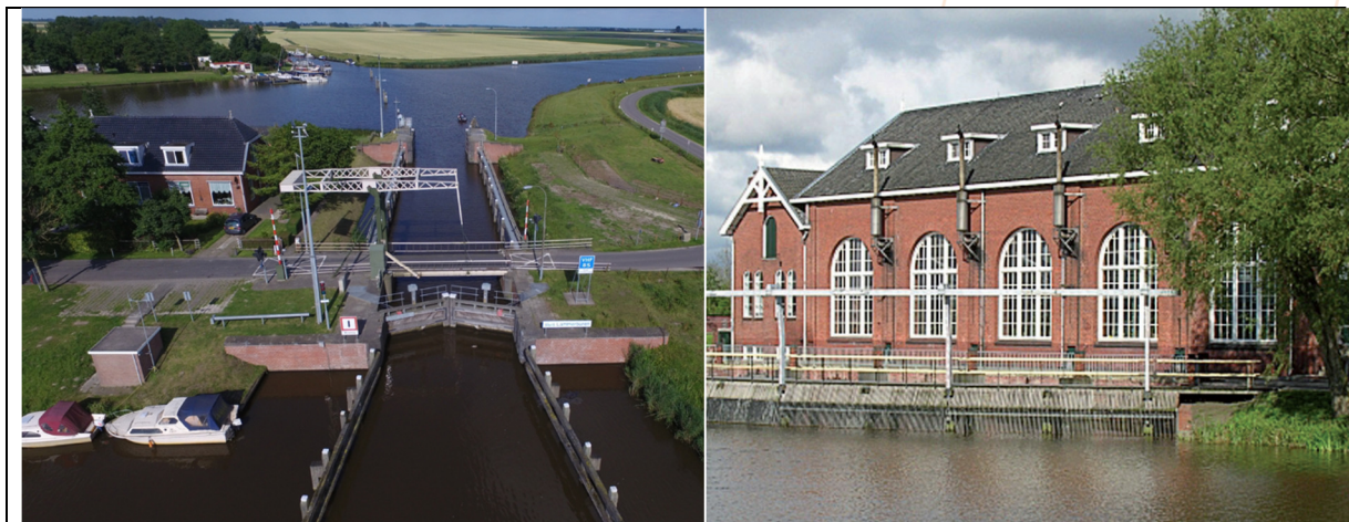
Figuur 3.2 Sluis Lammerburen en gemaal de Waterwolf
