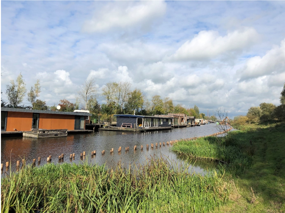
Figuur 1 Natuurvriendelijke oever in aanleg bij de Zuidwending. Een steile oever of een beschoeide oever biedt weinig groeimogelijkheden voor diverse waterplantensoorten. Een natuurvriendelijke oever (NVO) met een flauw talud biedt ruimte voor een diversiteit aan planten en schuilplekken voor vissen en macrofauna. Tevens kunnen te water geraakte dieren uit het water komen via een NVO. Hiermee verkleinen we de kans op verdrinking voor bijvoorbeeld ree en haas.
