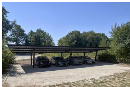
Figuur 4: zonnepanelen als overkapping parkeren © HILBERINKBOSCH architecten
