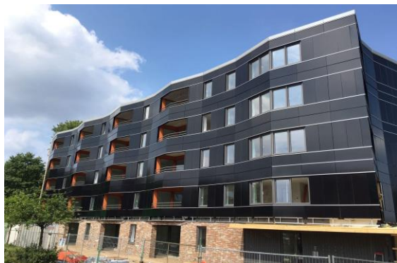
Figuur 1: zonnepanelen in gevels © eigenenergie.net
