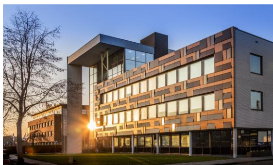
Figuur 5: zonnepanelen in de gevel © Solarix
