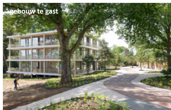
Lichte architectuur, zwevend gebouw, ondergeschikt aan groen, bescheiden architectuur, glas weerspiegelt groen (Bosgebouw Klingelbeek, Dyvik Kahlen)
