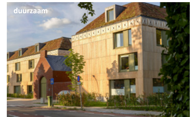
Duurzaam gebouw, groen in dakvlak; nestkast ingezet als architectonisch element. Hortus Ludi (Studio Architectuur Maken)
