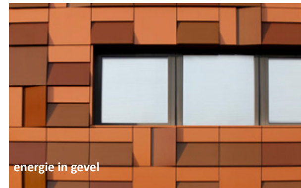
PV-panelen geïntegreerd in de gevel (Solarix design panels)
