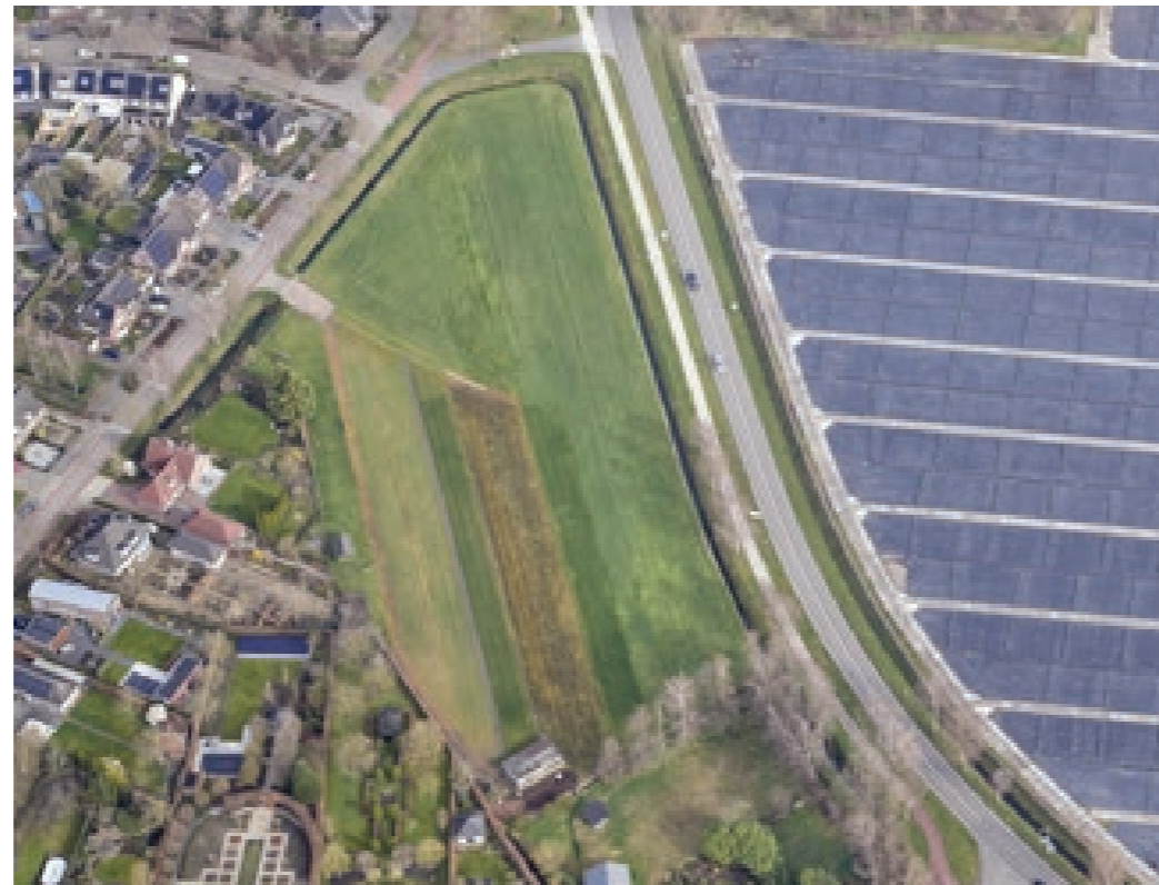
Oblique luchtfoto potentiële ontwikkellocatie Lieshoutseweg - Ruitersweg
