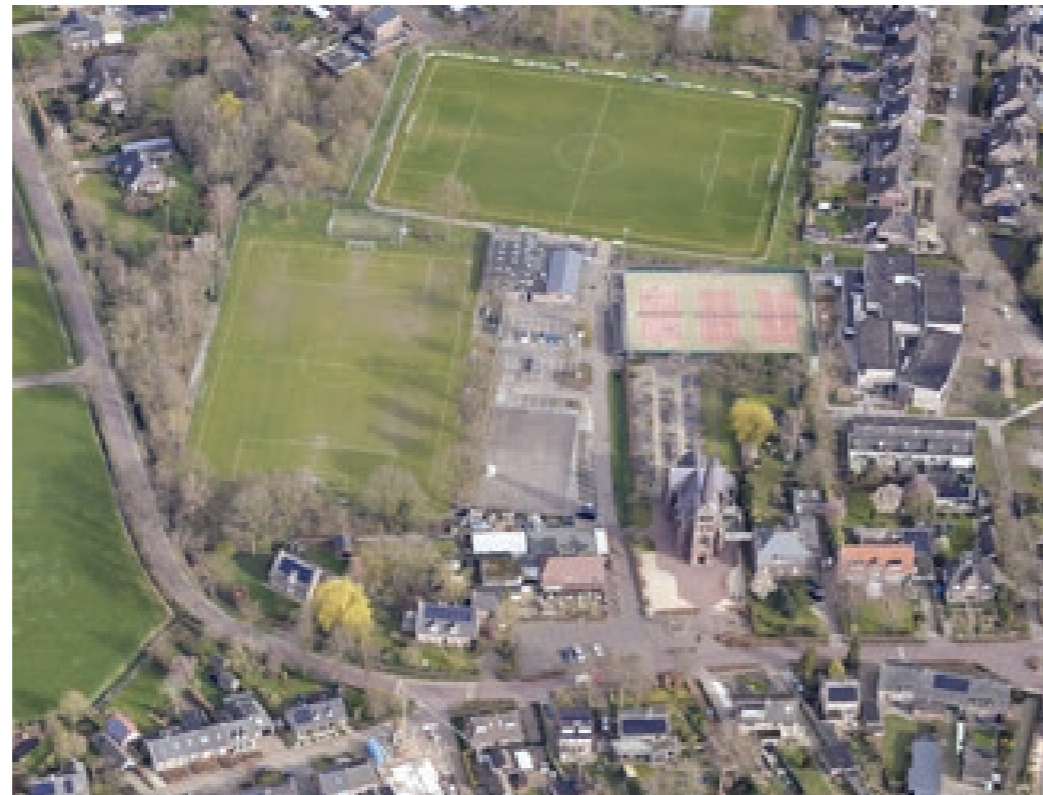
Oblique luchtfoto potentiële ontwikkellocatie sportpark
