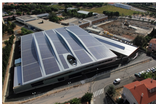
Figuur 6: Flexibele zonnepanelen op dak © Perpignan Kalzip
