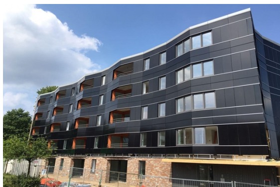
Figuur 1: zonnepanelen in gevels © eigenenergie.net
