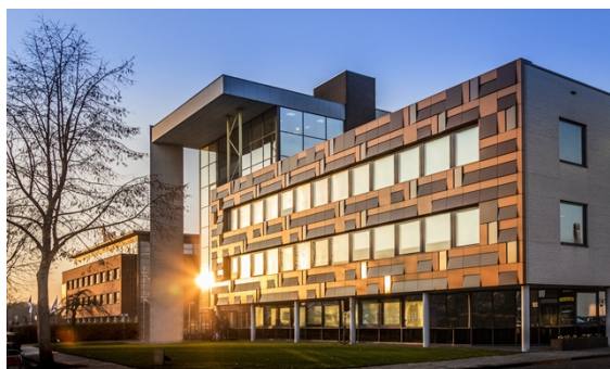
Figuur 5: zonnepanelen in de gevel © Solarix
