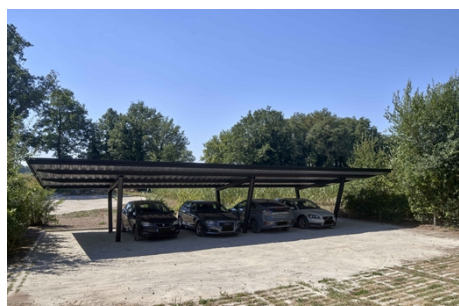
Figuur 4: zonnepanelen als overkapping parkeren © HILBERINKBOSCH architecten
