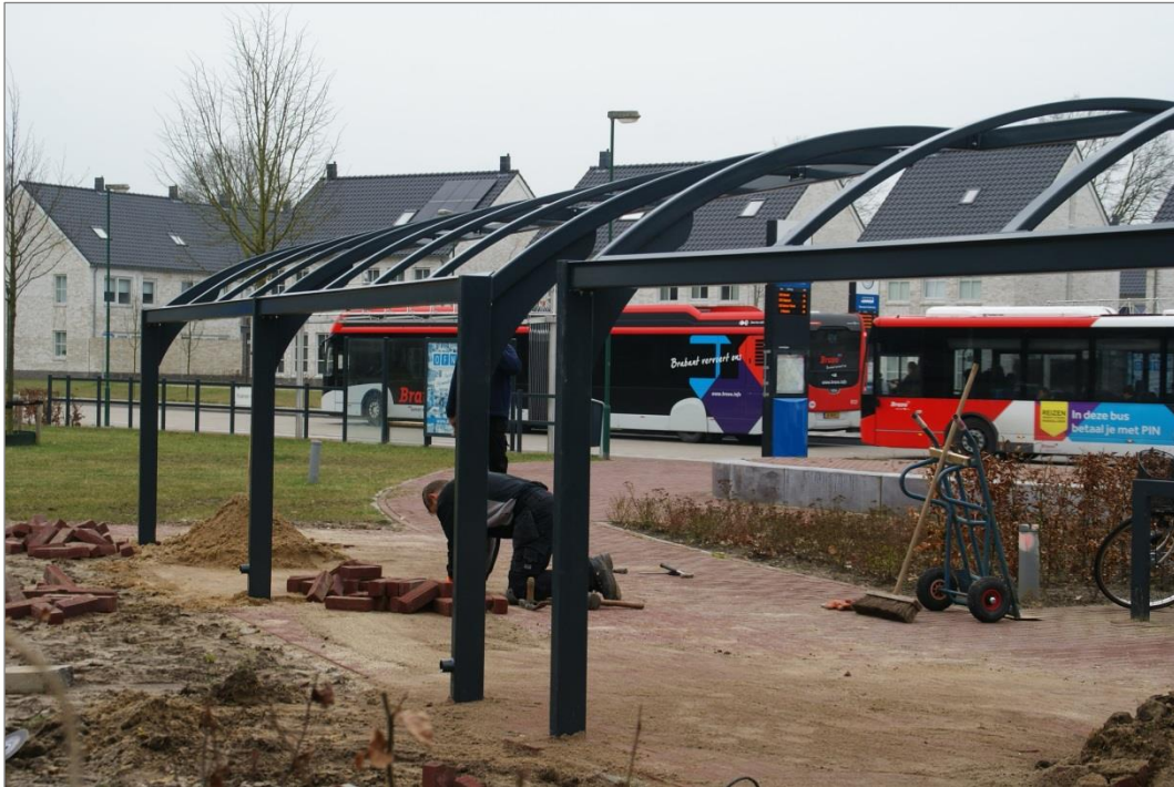
figuur 1: wegwerkzaamheden in Nueneen
