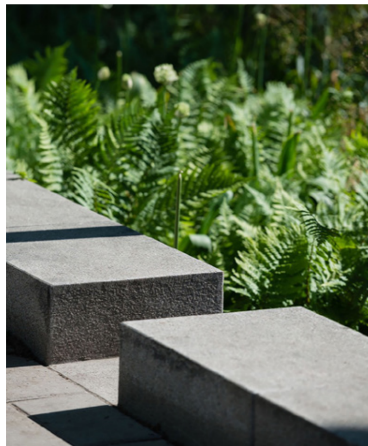
Water kan passeren naar het groen
