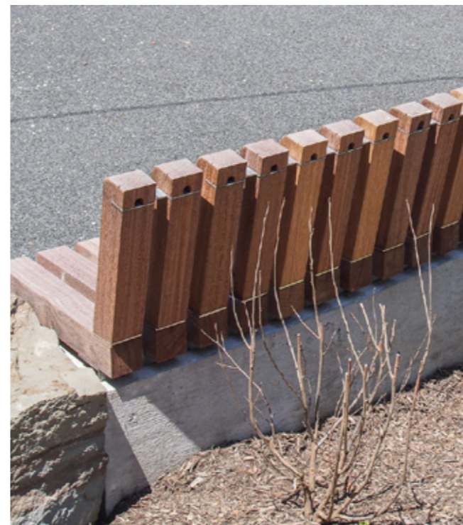
— Zitelementen zijn een houten toevoeging bovenop de betonnen randen
