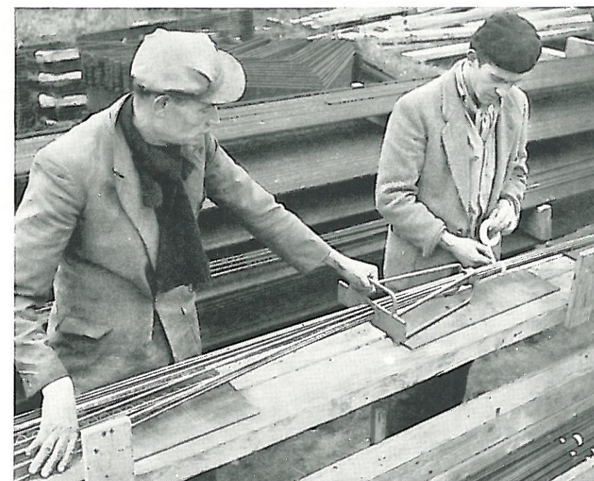
Figuur 2 Vervaardigen van een Freyssinetkabel.
