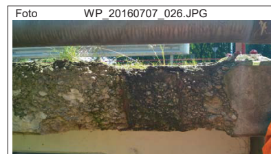
Betonschade schamkant
