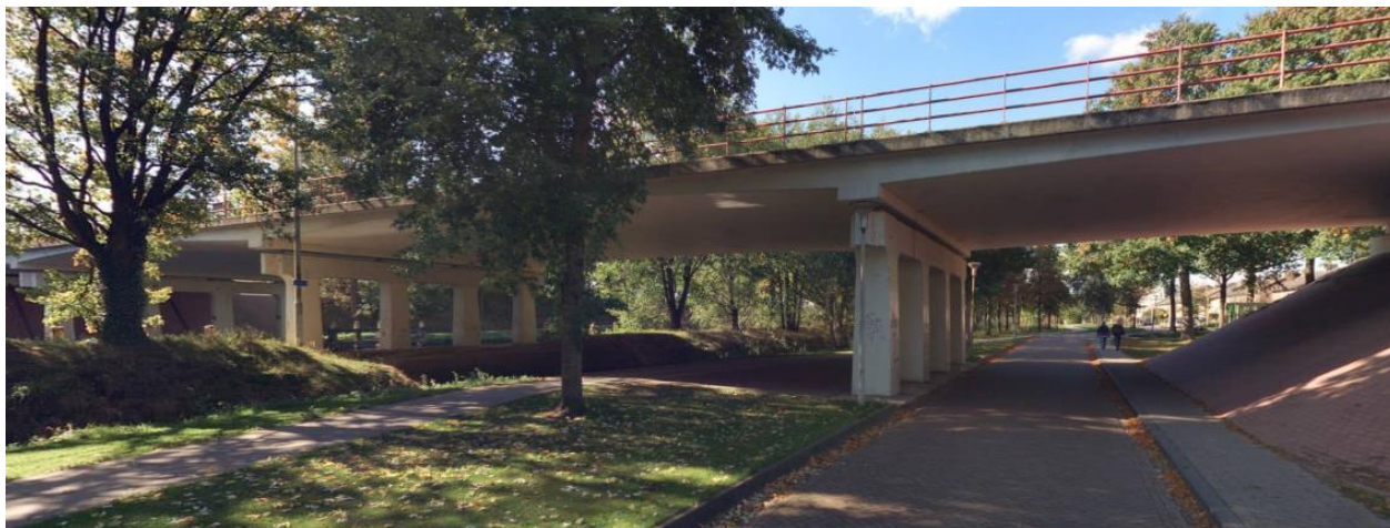
Figuur 9: Aanzicht van de brug [bron: Streetsmart Cyclomedia, 2022].
