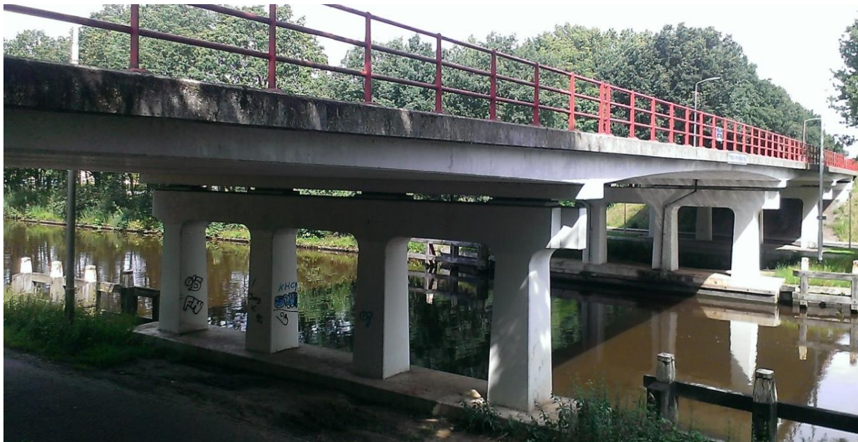
Figuur 5: Zijaanzicht van de brug (eigen foto, medio 2016).
