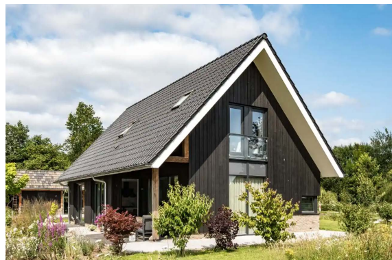
Zwart / donker hout als hoofdmateriaal en beperkt overstek aan de straatzijde (bron: Selekthuis)
