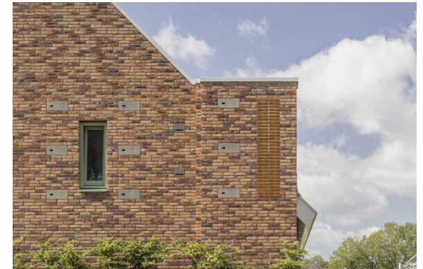
Onderbreking dakhelling met detail metselwerk (bron: Wouter van der Sar)
