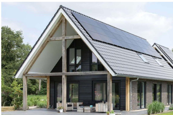
Langgerekt bouwvolume met transparante gevel en groot dakoverstek aan de achterzijde (bron: Presolidhome)
