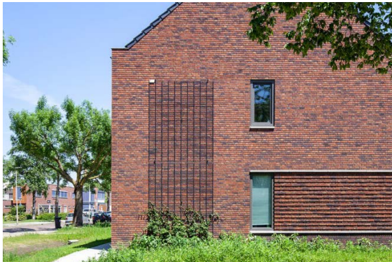
Detail in metselwerk (bron: Pauwert)
