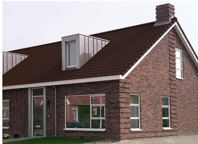
Zorgvuldige detaillering metselwerk voorgevel en zijgevel Bron: Bouwbedrijfhiemstra.nl
