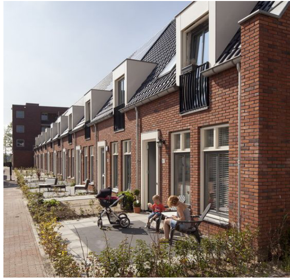
1 | Voorbeeld van rood bruin metselwerk met antraciete dakpannen.
