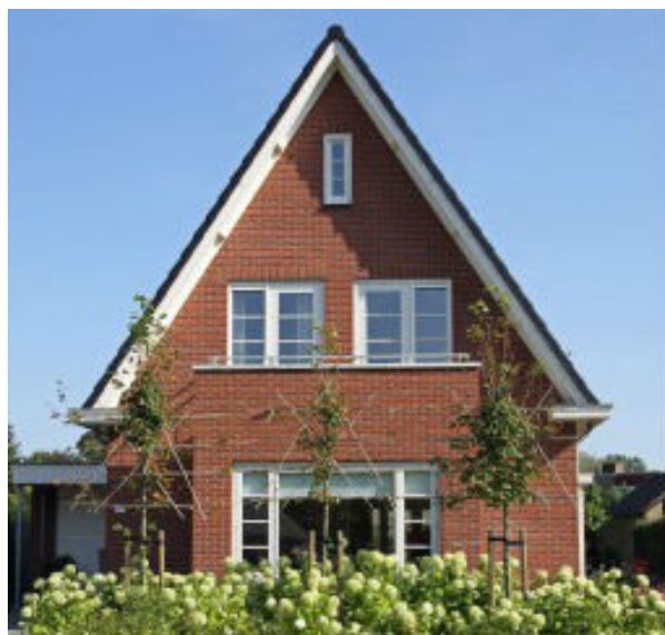
5 | Aanbouw is ondergeschikt aan het hoofdvolume.
