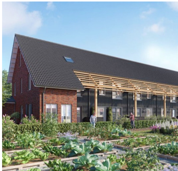
3 | Voorbeeld voor de meest zuidelijke woningen met 2 bouwlagen met kap. Waarbij een zachtere overgang wordt gecreëerd naar het omliggende landschap. In deze referentie d.m.v. een knip in het volume en een meer semi transparant dak en een lagere goothoogte.
