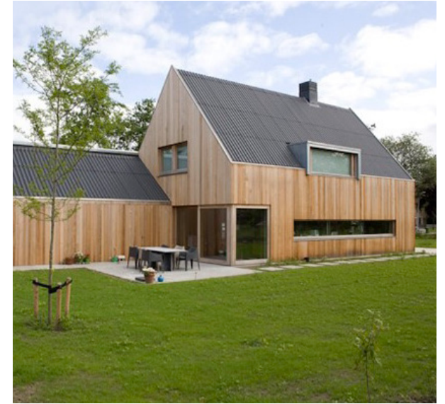
3 | Kozijnen, ramen, deuren, dakgoten etc. uitgevoerd in middentoon.
