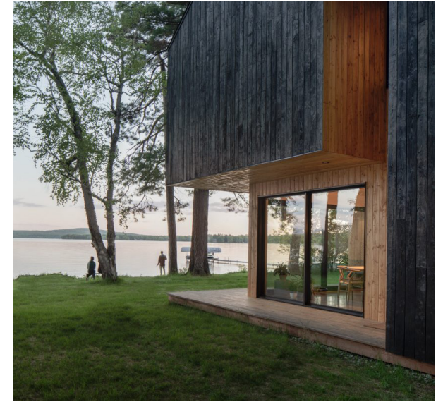
3 | Loggia die binnen zorgt voor meer schaduwwerking.
