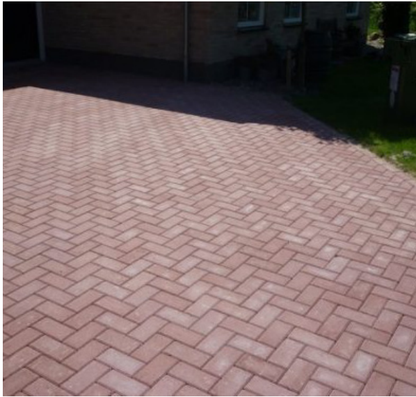
1 | De wegen zijn voorzien van rood bruine betonklinkers.
