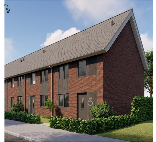
2 | Kozijnen, ramen, deuren, dakgoten etc in middentoon. Voorbeeld van rood bruin metselwerk met antraciet pannendak.
