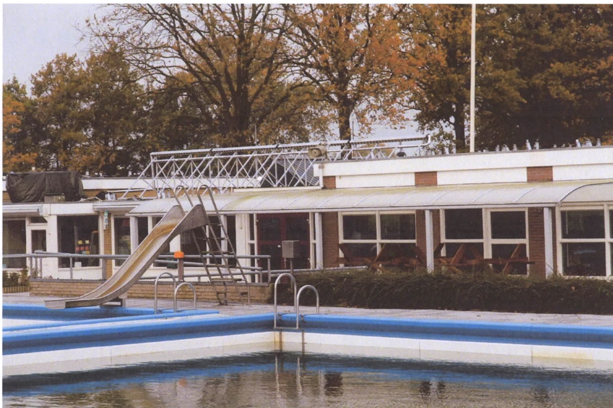
De stellage voor de zonnecollectoren is geplaatst.
