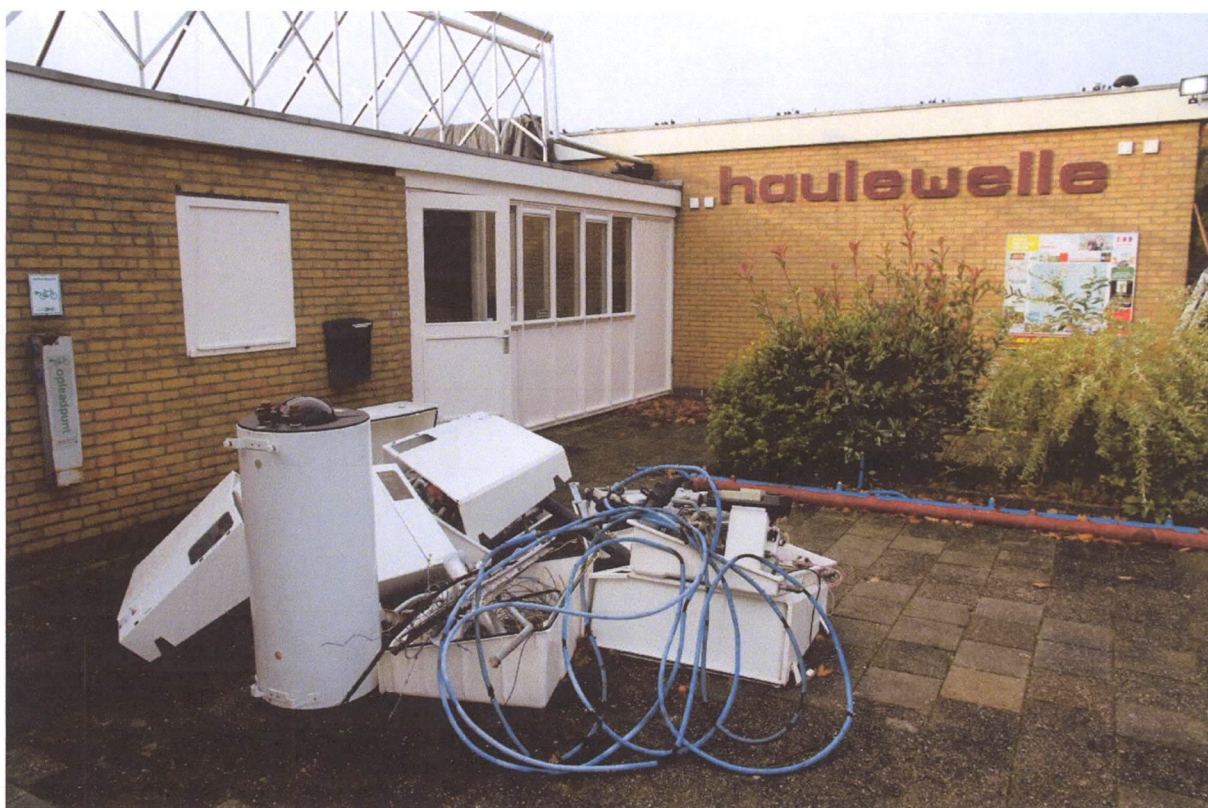
De ketels zijn uit de machinekamer gesloopt.
