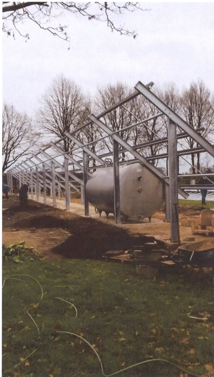
De stellage waarop de heat pipes / zonnepanelen geplaatst worden.
