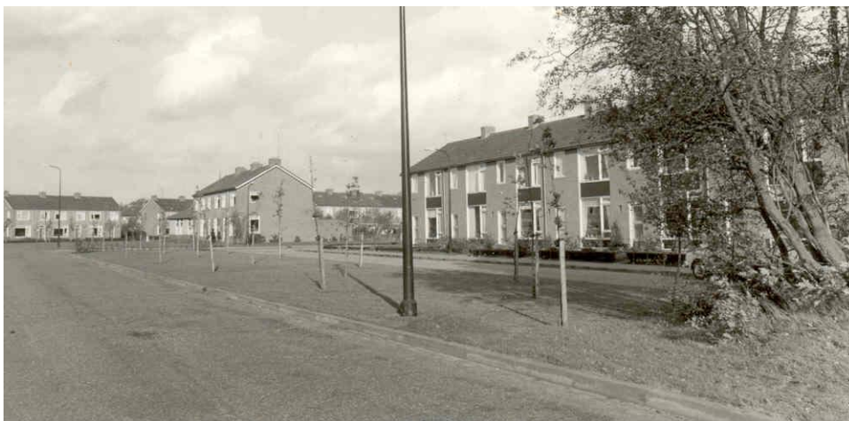
Woningen aan de Prakkenlaan in Oosterwolde.
