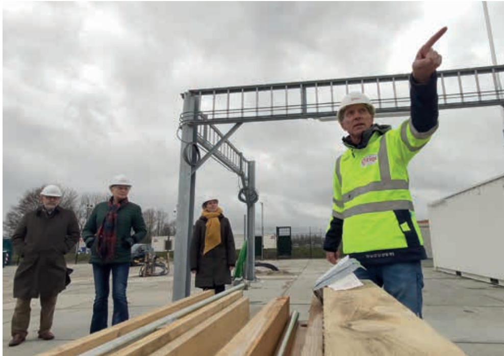
Ben Tubben van Alliander leidt v.l.n.r. de wethouders Rob Jonkman van Opsterland, Hanneke Zonderland van Weststellingwerf en Fimke Hijlkema van Ooststellingwerf rond bij de waterstofinstallatie in aanbouw. Foto: gemeente Ooststellingwerf
