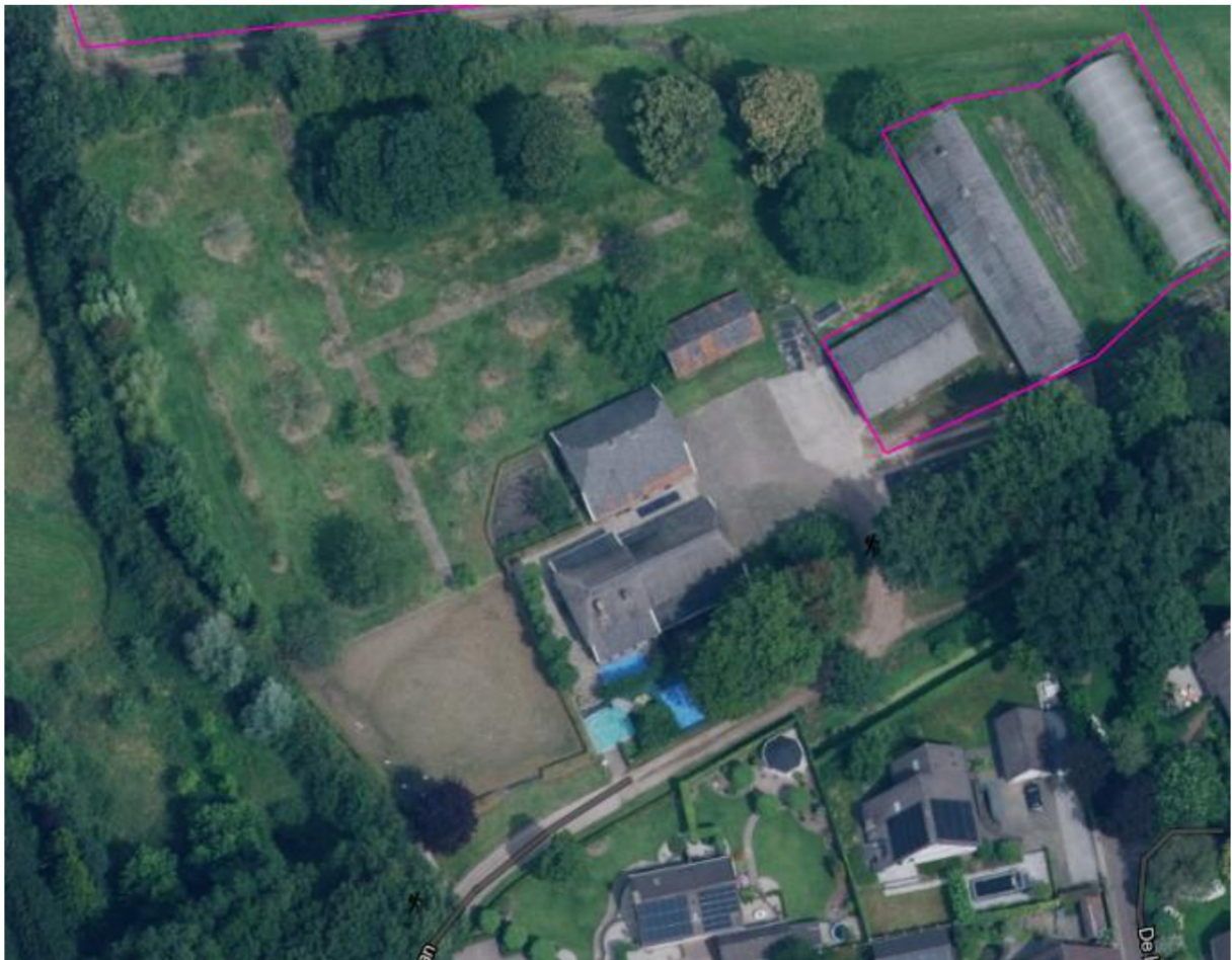
Afbeelding 1. Luchtfoto van het betreffende perceel en de te verwijderen schuren en kweektunnel (Esri, 2025).
