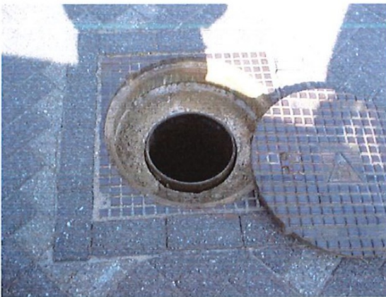
Foto's 5 en 6 : voorbeeld van zwaar verkeerdeksel op funderingsplaat om controleputkoker
