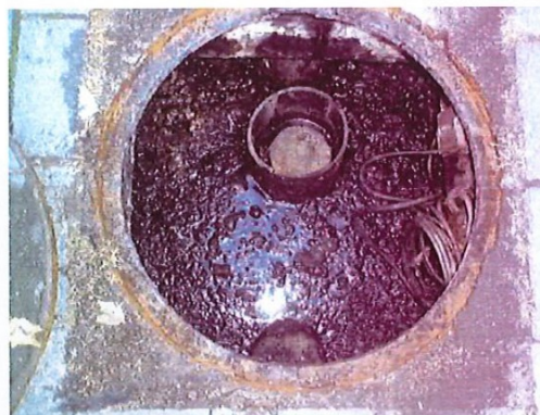
Foto 2 : gecombineerde slibvangput/olieafscheider
