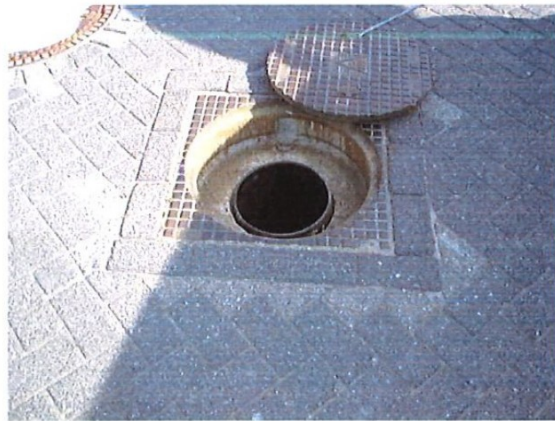
Foto's 5 en 6 : voorbeeld van zwaar verkeerdeksel op funderingsplaat om controleputkoker
