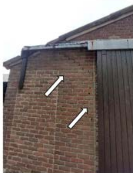
Afbeelding 5. Potentiële openingen naar de spouwmuur en geschikt als vleermuisverblijfplaats.
