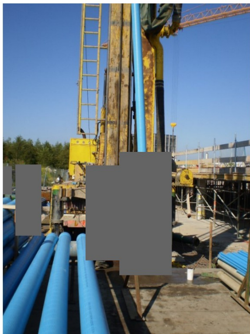
Figuur 6.2 | Inbouwen boorgat open bodemenergiesysteem.
