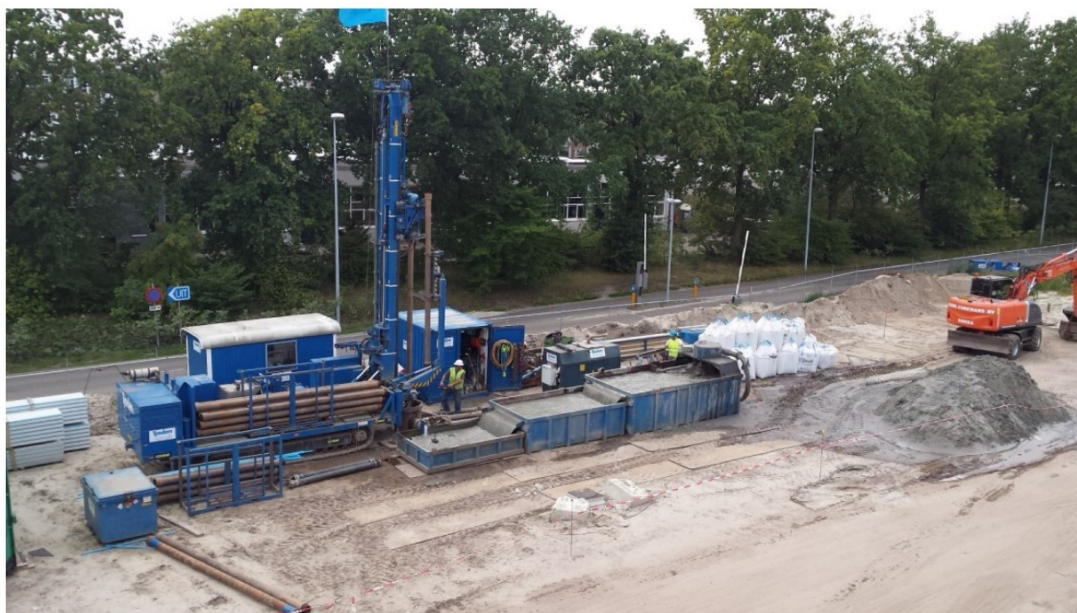
Figuur 6.1 | Voorbeeld booropstelling t.b.v. een open bodemenergiesysteem.
