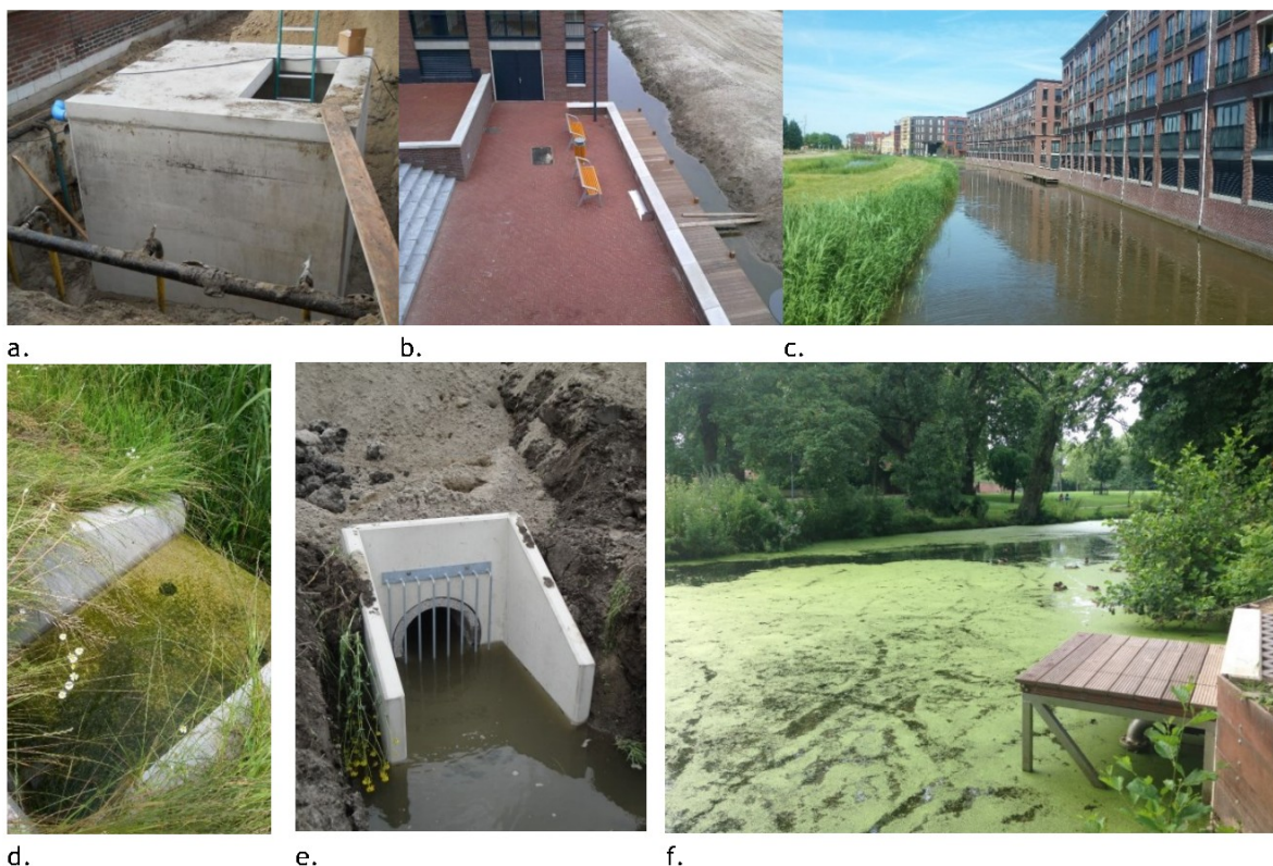
Figuur 2.5 | a. Ondergrondse technische ruimte TEO-systeem in aanleg; b. ondergrondse technische ruimte TEO-systeem afgewerkt met putdeksel; c. inlaat TEO-systeem afgewerkt onder steiger; d. uitlaat (uitstroombak) TEO-systeem in werking; e. uitlaat (uitstroombak) TEO; f. inlaat TEO-systeem afgewerkt onder steiger.
