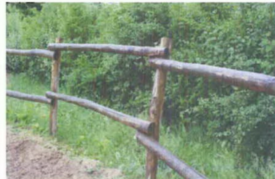
Figuur 2 Detail houtwerk
