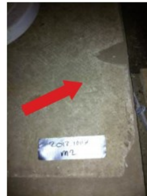
Foto 4 (M2): Losse plaat
