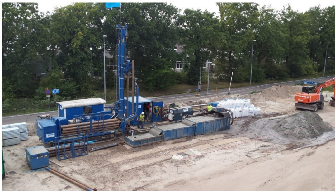
Figuur 6.1 | Voorbeeld booropstelling t.b.v. een open bodemenergiesysteem.
