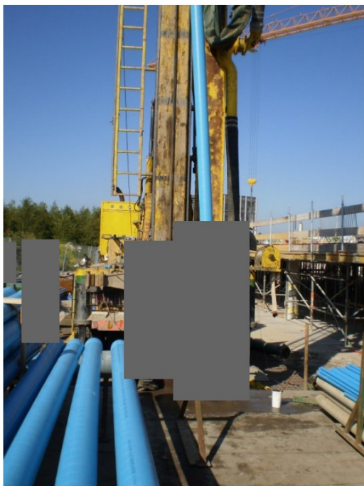
Figuur 6.2 | Inbouwen boorgat open bodemenergiesysteem.
