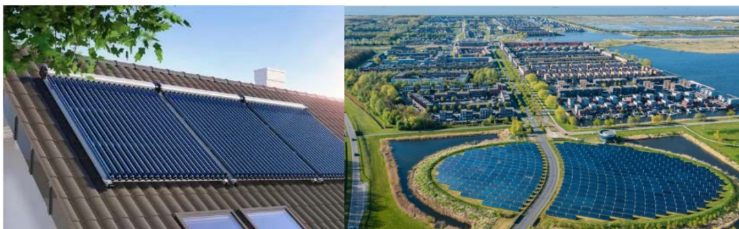
Figuur 2.6 | Individuele zonneboiler (links). Bron: https://www.eigenhuis.nl . Collectief systeem met PT-panelen (rechts). Bron: https://www.flevoland.nl
