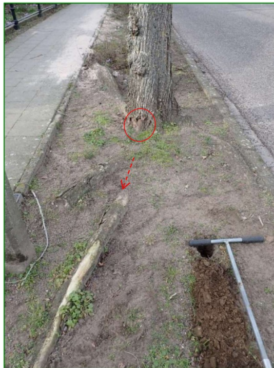
Foto 27: schade aan oppervlakkige wortel en de aanhechting aan de stam
