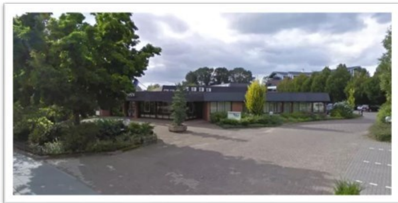
Transformatie bedrijfslocatie Vorden
