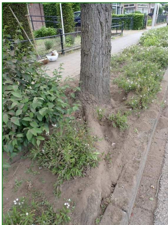
Foto: ook aan de andere zijde, groeit een oppervlakkige wortel langs de opsluitband
