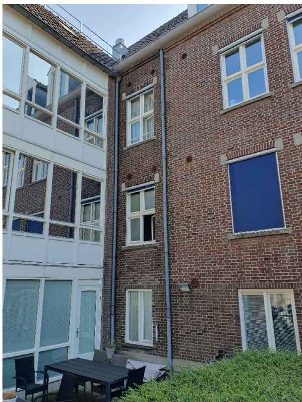
Afbeelding 11: Aansluiting van nieuwbouw (links) aan oudbouw (rechts) in het centraal-westelijke deel bij boring 7. Het terras ligt laag ten opzichte van de straat (niet zichtbaar). De foto is gemaakt in zuidoostelijke richting (september 2025).
