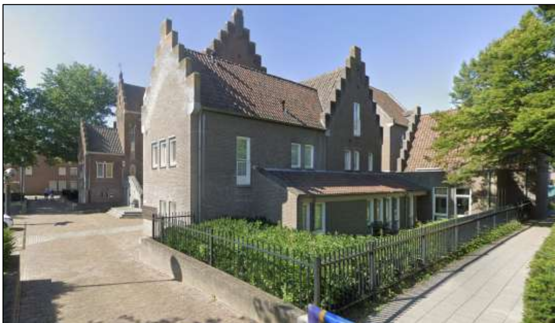
Aanzicht zuidoostzijde vanaf Raadhuisplein (bron: Google Streetview)
