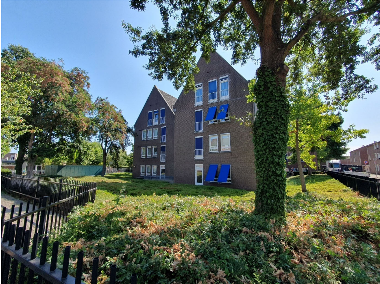
Afbeelding 10: De noordwesthoek van het plangebied met een laagte rondom de bebouwing, kijkende in zuidoostelijke richting (september 2025).
