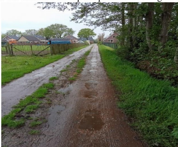
Foto 11: het water op het pad kan niet weg en de sloten blijven vol staan.
